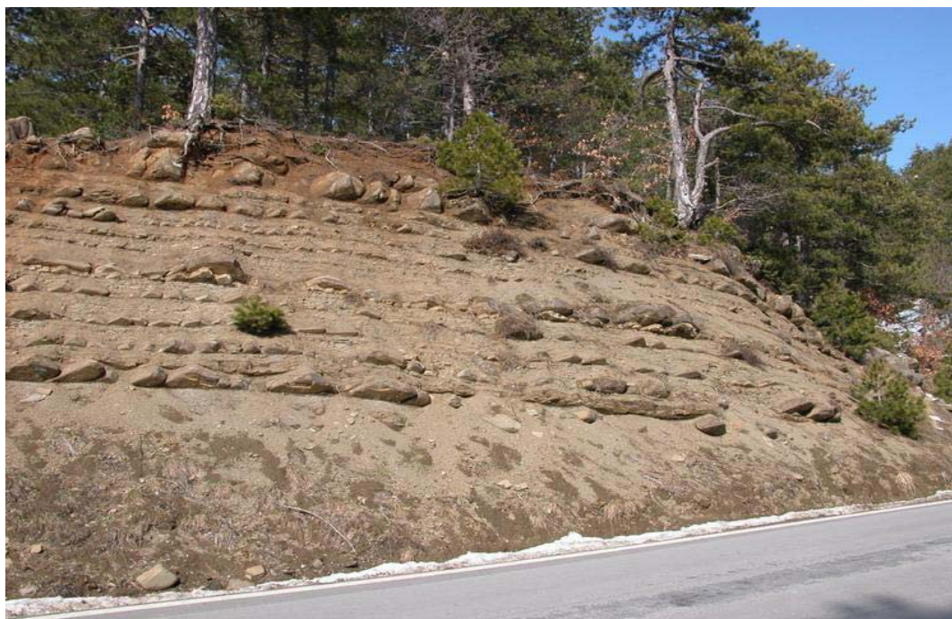
Εικόνα 4.2 Τυπική μορφή εναλλαγών ψαμμιτών και ιλυολίθων σε ισομερή ποσοστά σε επιφανειακό σχηματισμό μολάσσας (από Β. Μαρίνος, 2007)
