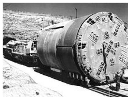
Εικ.1. Ένα μηχάνημα εκσκαφής σηράγγων που χρησιμοποιήθηκε στην Νεβάδα των Η.Π.Α.
