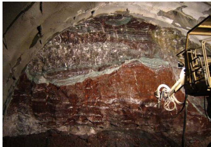
Εικόνα 2. Εμφάνιση ραδιολαριτών στο μέτωπο της σήραγγας Αρτεμεισίου
