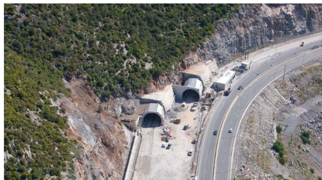
Εικόνα 3: Αεροφωτογραφία των στομιών εξόδου της σήραγγας Στέρνας. Διακρίνονται οι κατασκευές των αντιβάρων καθώς και η κατασκευή του Cut & Cover εξόδου.
