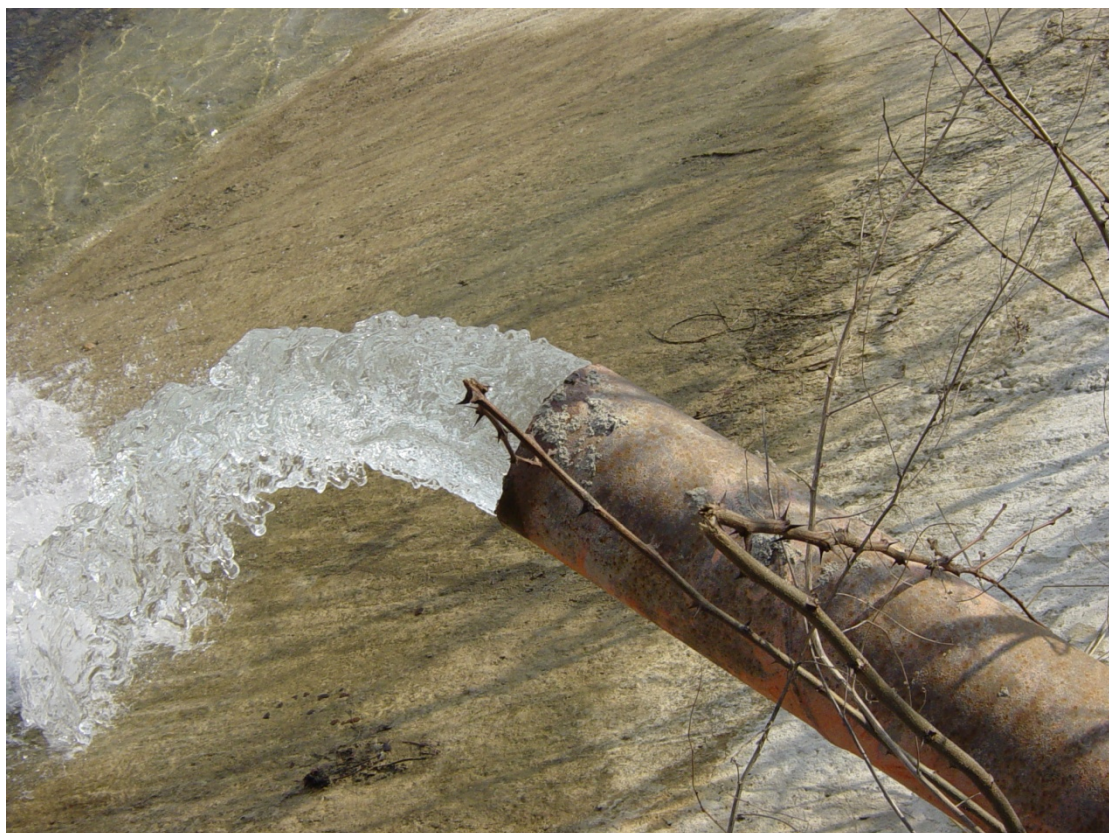
Εικόνα 6.1.1. Αγωγός (αρχείο Ε.Υ.Α.Θ)
