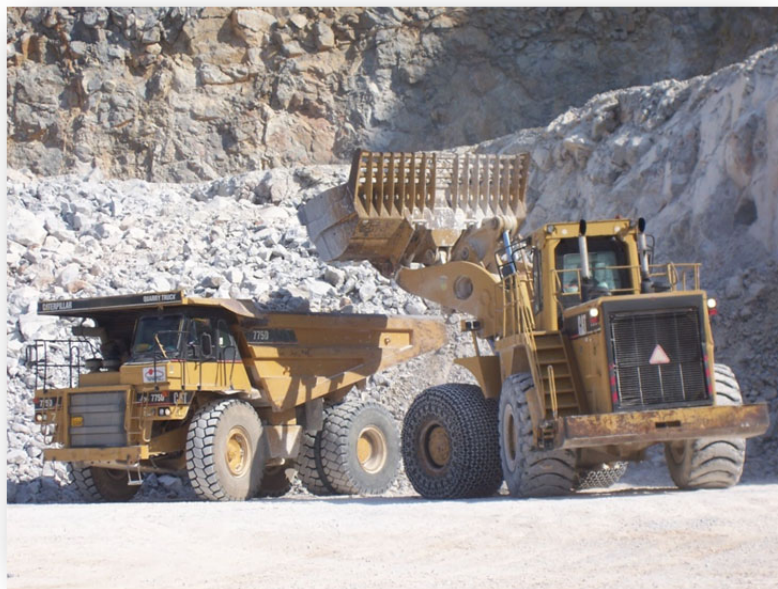
Σχήμα 5.4.3. Ο εκσκαφέας και ο φορτωτής κατά τη διαδικασία φόρτωσης των εξορυσσόμενων τεμαχών στο μέτωπο.
