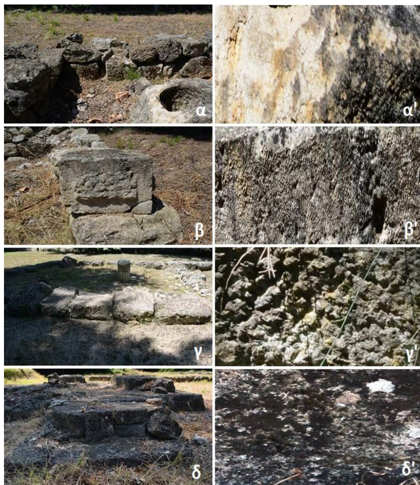
Εικόνα 8.2.14. Χαρακτηριστικές εικόνες της επιφάνειας των δομικών λίθων, α. γενική εικόνα τμήματος του νοτιοανατολικού Οίκου, α'. λεπτομέρεια εικόνας τμήματος του νοτιοανατολικού Οίκου, β. γενική εικόνα δομικού λίθου ελληνοιστικής στοάς, β'. λεπτομέρεια εικόνας δομικού λίθου ελληνοιστικής στοάς, γ. γενική εικόνα βορειοανατολικής πλευράς του ναού του Ασκληπιού, γ'. λεπτομέρεια εικόνας βορειοανατολικής πλευράς του ναού του Ασκληπιού, δ. γενική εικόνα βόρειας πλευράς του μεγάλου βωμού της Δήμητρας, δ'. λεπτομέρεια εικόνας βόρειας πλευράς του μεγάλου βωμού της Δήμητρας
