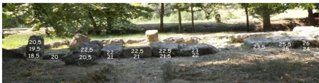
Σχήμα 8.2.1. Διάγραμμα θερμοκρασιών της ανατολικής πλευράς του Ναού του Ασκληπιού, Σεπτέμβριος 2011 Εικόνα 8.2.1. Φωτογραφία της ανατολική πλευράς του ναού του Ασκληπιού κατά τη θερμομέτρηση των λίθων, Σεπτέμβρης 2011
