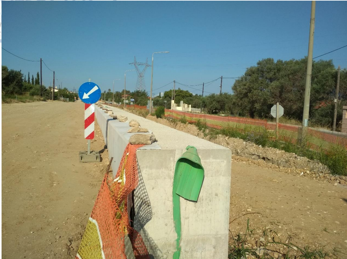
Εικόνα 7: Κεφαλόδεσμοι- τοιχία αντιστήριξης
