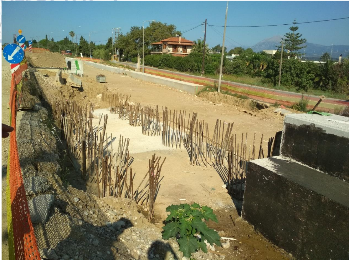
Εικόνα 5: Κεφαλόδεσμος – συνδετήριος δοκός των σκυροδετημένων φρεατοπασσάλων.
