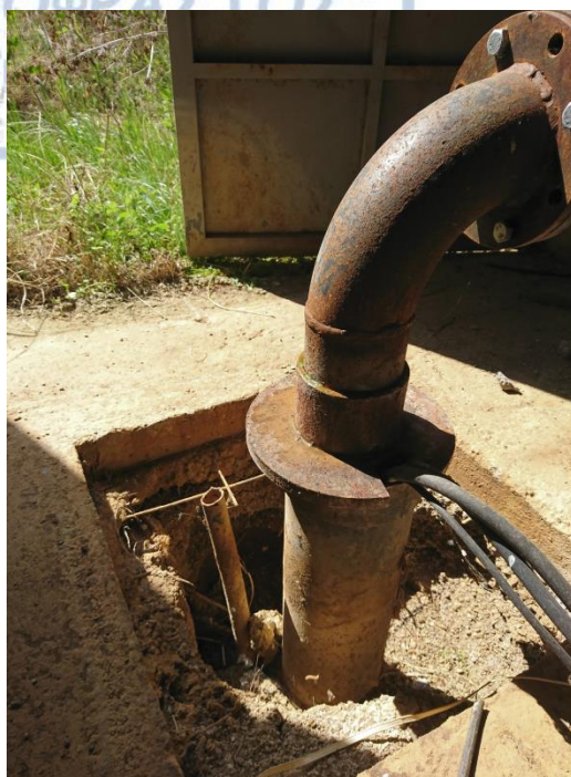
Σχήμα 4.9: (αριστερά) υδρευτική γεώτρηση της περιοχής, (δεξιά) εγκαταλειμμένη αρδευτική γεώτρηση μεγάλου βάθους, ανορυγμένη στον καρστικό υδροφόρα.
