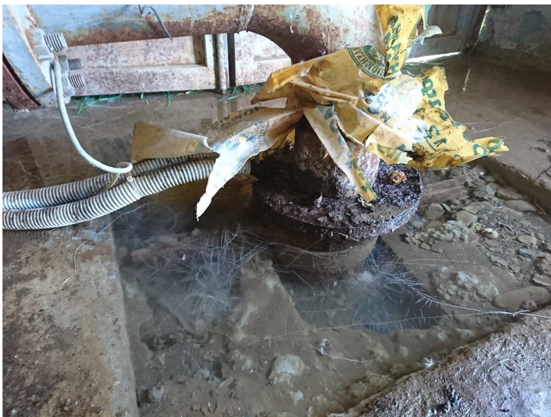
Σχήμα 4.8: Αρτεσιανισμός σε γεώτρηση του πορώδους υδροφορέα.
