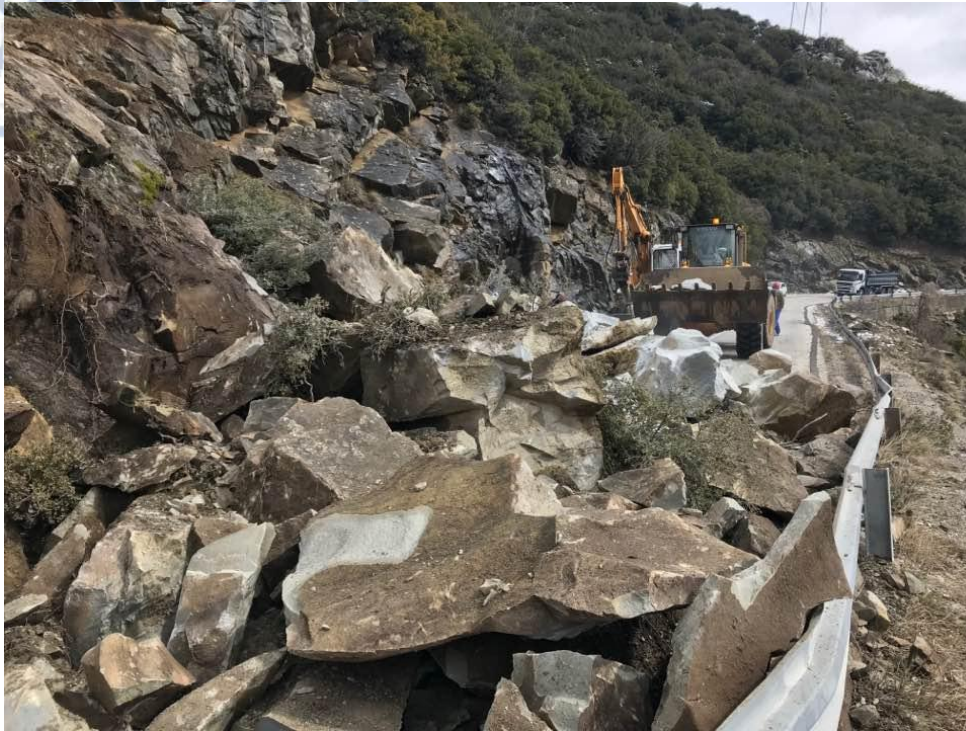
Εικόνα 2.13 Βραχοκατάπτωση στο Βοτονόσι(tyros-i.g)
