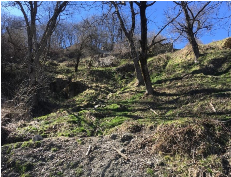
Εικόνα 5.9 Έντονη ανωμαλία εδάφους που δείχνει την μετακίνηση
