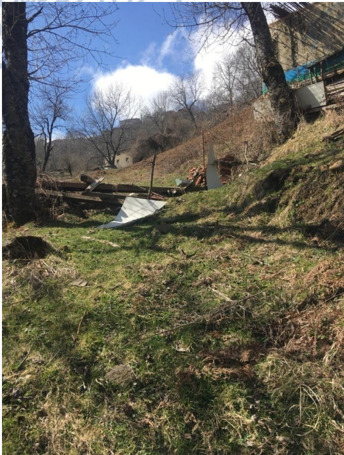
Εικόνα 5.17 Ανώμαλη επιφάνεια κάτω απο τον δρόμο
