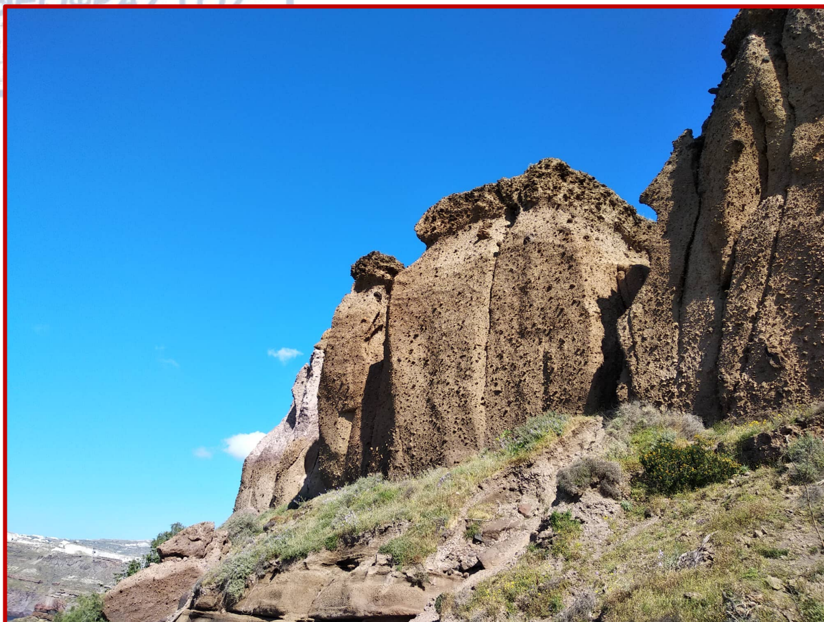
Εικόνα 12. Υπαίθρια εικόνα της θέσης που έγιναν παρατηρήσεις για μετατοπίσεις. Όπως φαίνεται όντως έχει φύγει υλικό από τη συγκεκριμένη(στη κορυφή) και έχει αποκαλυφθεί καινούργια επιφάνεια
