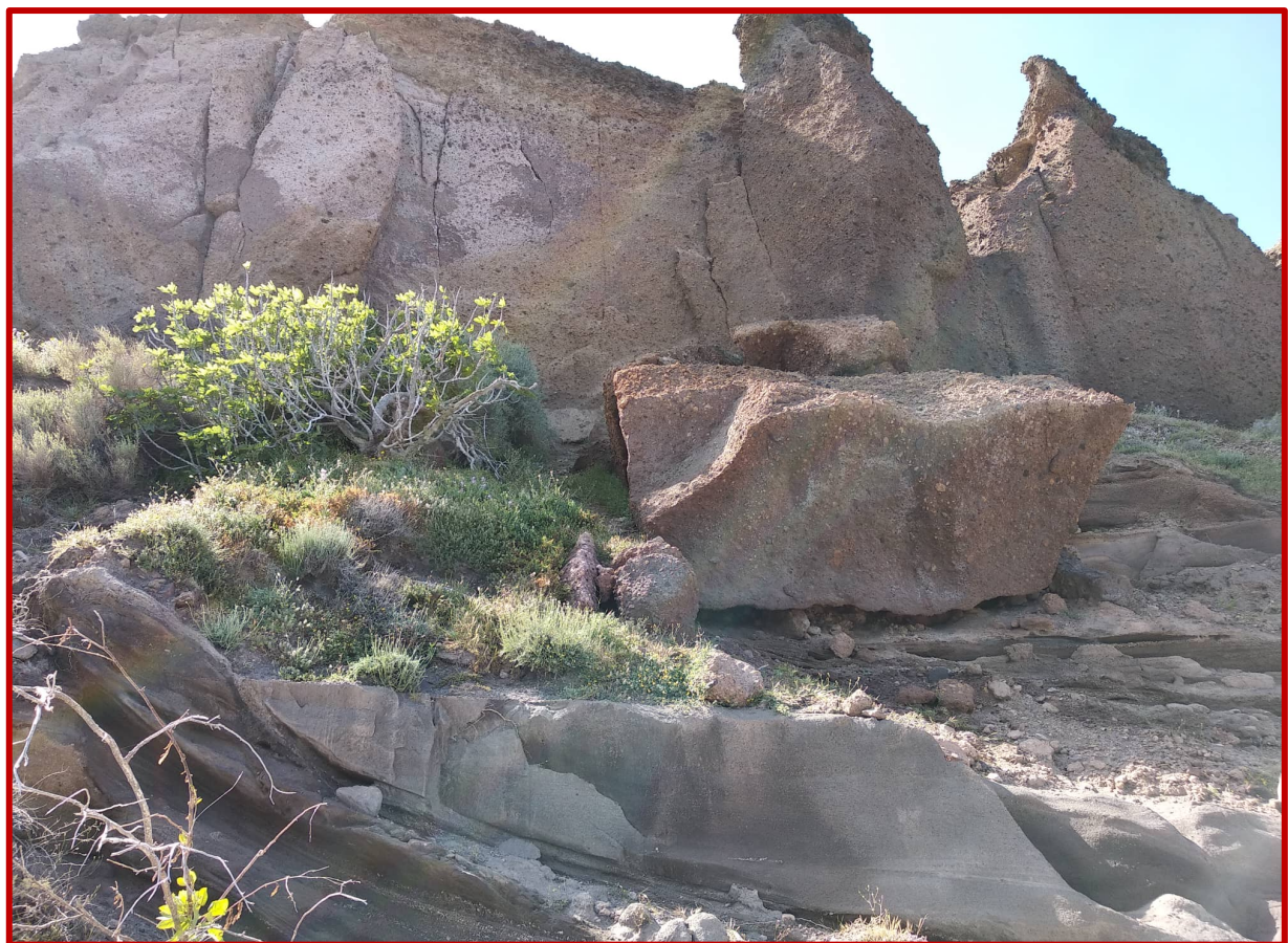
Εικόνα 13. Υπαίθρια εικόνα της περιοχής με τις κύριες μετατοπίσεις. Φαίνονται και αρκετά block ιγκνιμβρίτη που έπεσαν στο παρελθόν καθώς και οι εντόνως ανοιγμένες εφελκυστικές ρωγμές πίσω από τα επικρεμάμενα τεμάχη.
