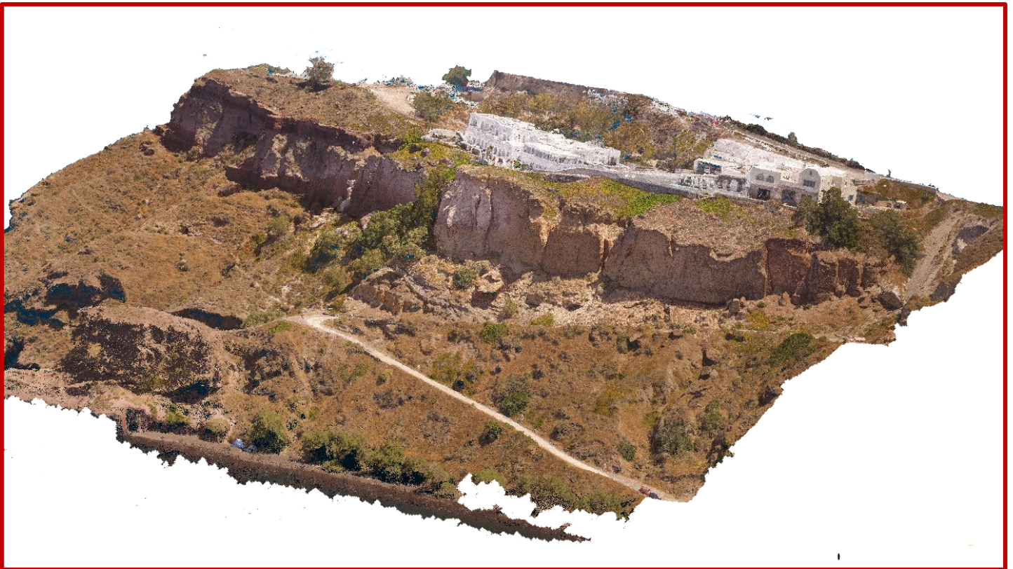
Σχήμα 25. Το τρισδιάστατο μοντέλο της περιοχής μελέτης που κατασκευάστηκε μέσω UAV το 2018.
