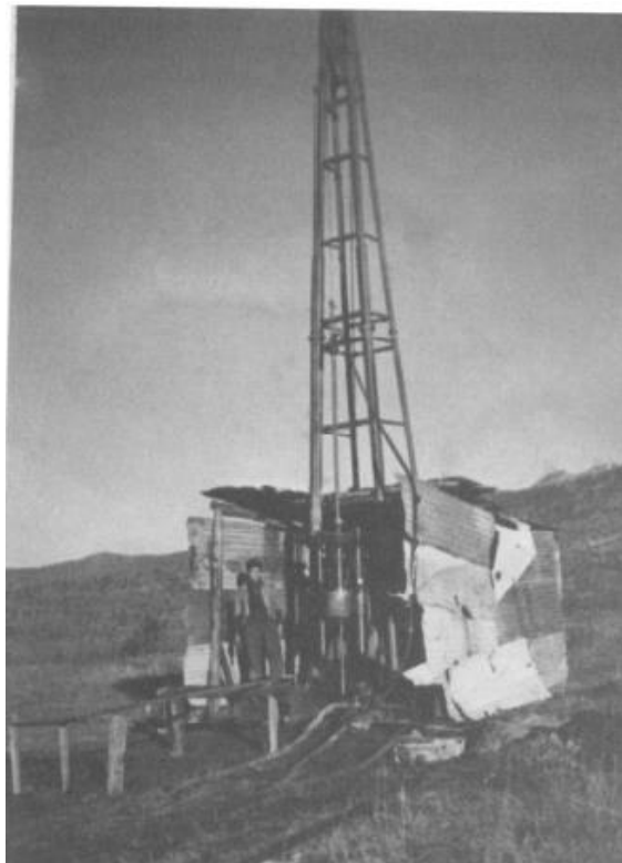
Εικόνα 5.2: Γεωτρύπανο εποχής στην περιοχή χρωμίου εκτελεί δειγματοληψία (Πολιτιστικός σύλλογος Χρωμίου).
