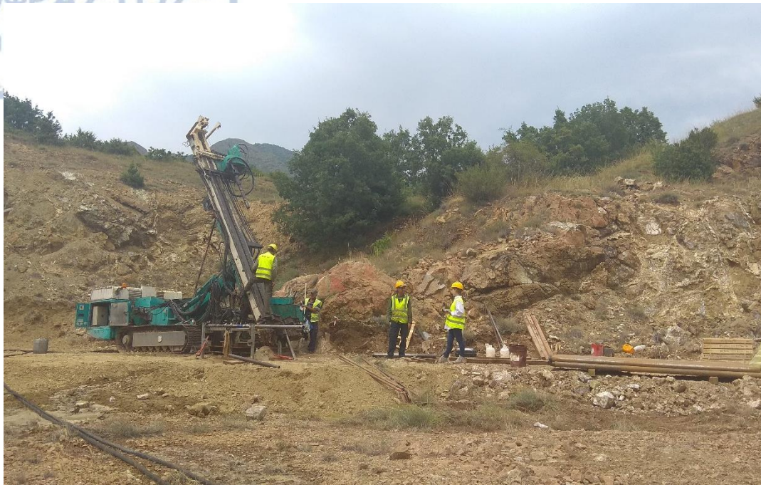
Εικόνα 6.1.1: Αυτοκινούμενο δειγματοληπτικό γεωτρύπανο κατά την διάρκεια της έρευνας (ΕΛΛΗΜΕΤ 2018).
