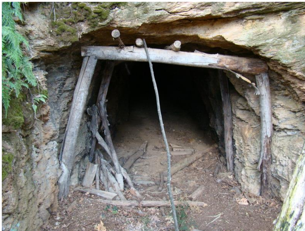
Εικ. 3.2.2. Πρόχειρα διανοιγμένη και στηριζόμενη στοά εκμετάλλευσης αντιμονίου στην περιοχή των Ριζανών.
