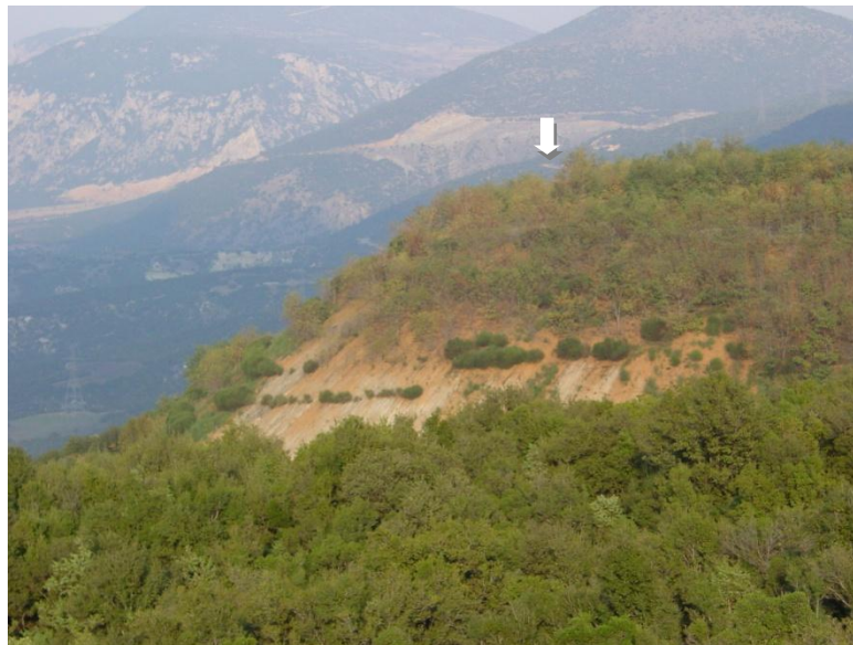
Εικόνα 6.15. Άποψη των στείρων του μεταλλείου μετά την παύση λειτουργίας του. Φαίνεται τόσο η φυσική κάλυψη με βλάστηση πλέον, όσο και οι αρχικές εργασίες αποκατάστασης. Το βέλος σημειώνει το σημείο λήψης της Εικόνας 6.14
