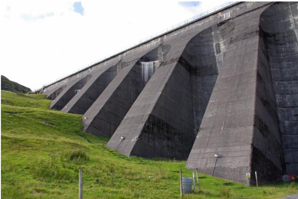
Εικόνα 5: Λεπτομέρεια αντηρίδων Αντηριδωτού φράγματος
