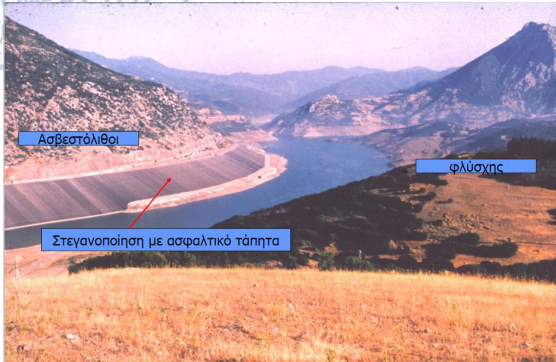
Σχήμα 12: Επικάλυψη με ασφαλτικό τάπητα μιας έκτασης ασβεστόλιθων στον ταμιευτήρα του φράγματος Μόρνου Φωκίδος
