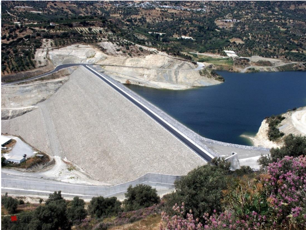
Εικόνα 1: Χωμάτινο - Λιθόρριπτο φράγμα
