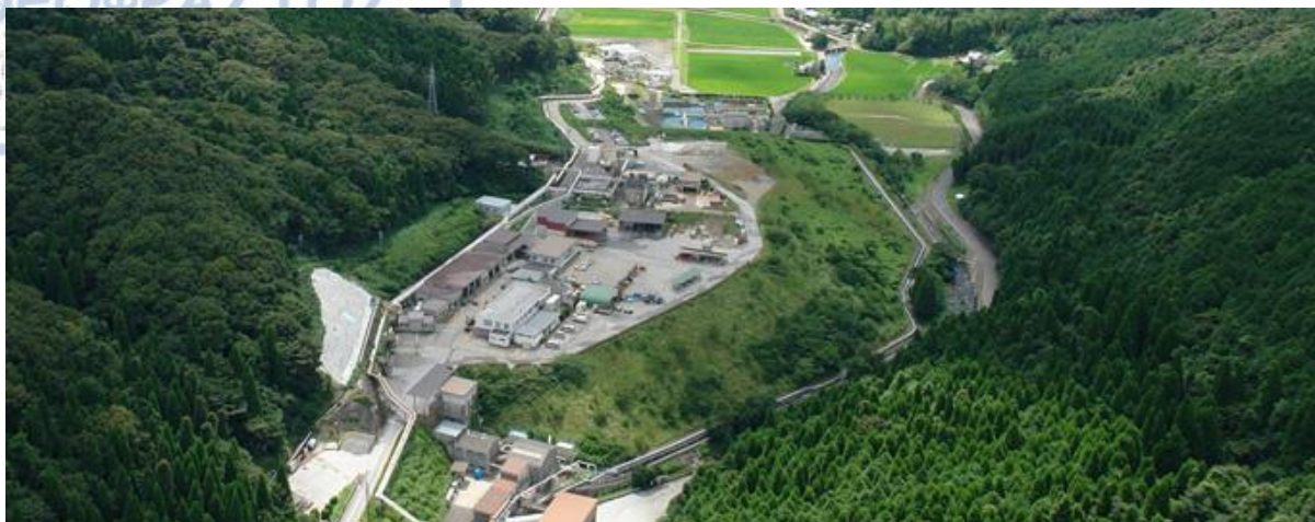
Εικόνα 19. Ορυχείο της περιοχής Hishikari, Japan (National Institute of Advanced Industrial Science and Technology(AIST) and Sumitomo Metal Mining Co., Ltd )
