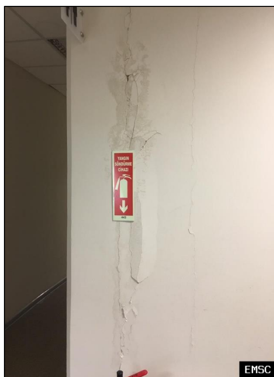
Σχήμα 2.3.3: Εσωτερικές ρωγμές και ζημιές σε κτήρια της Κωνσταντινούπολης (πηγή: https://www.emsc-csem.org/Earthquake/earthquake.php?id=794756#testimonies )
