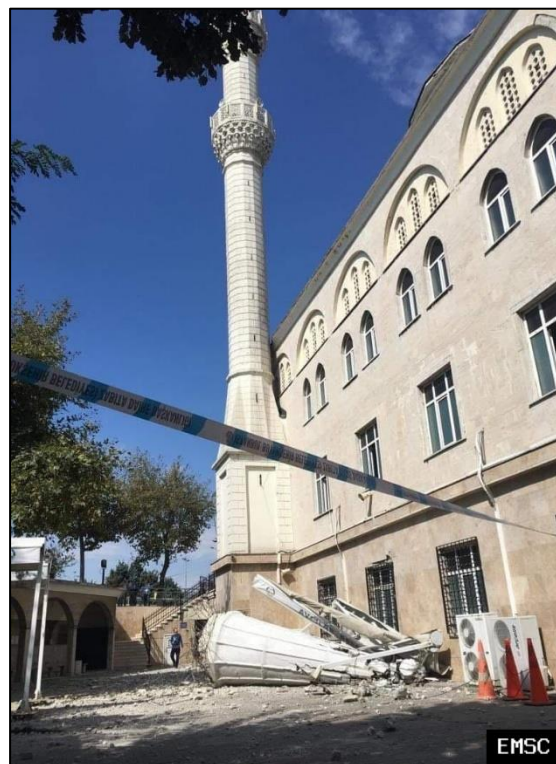
Σχήμα 2.3.2: Κατάρρευση μιναρέ σε τζαμί της συνοικίας Avcali (πηγή: https://www.emsc-csem.org/Earthquake/earthquake.php?id=794756#pics )
