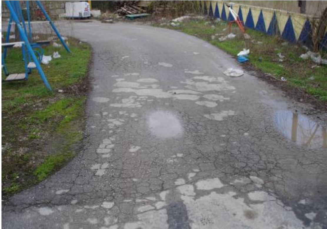
Εικόνα 7: Παρατηρούνται δύο παράλληλες ζώνες διάρρηξης στην άσφαλτο στη ΝΔ πλευρά του καταστήματος «ΕΓΝΑΤΙΑ». Η μια ζώνη φέρει μετάπτωση προς τα ΒΑ, ενώ η άλλη προς τα ΝΔ. (Χατζηπέτρος, 2006)
