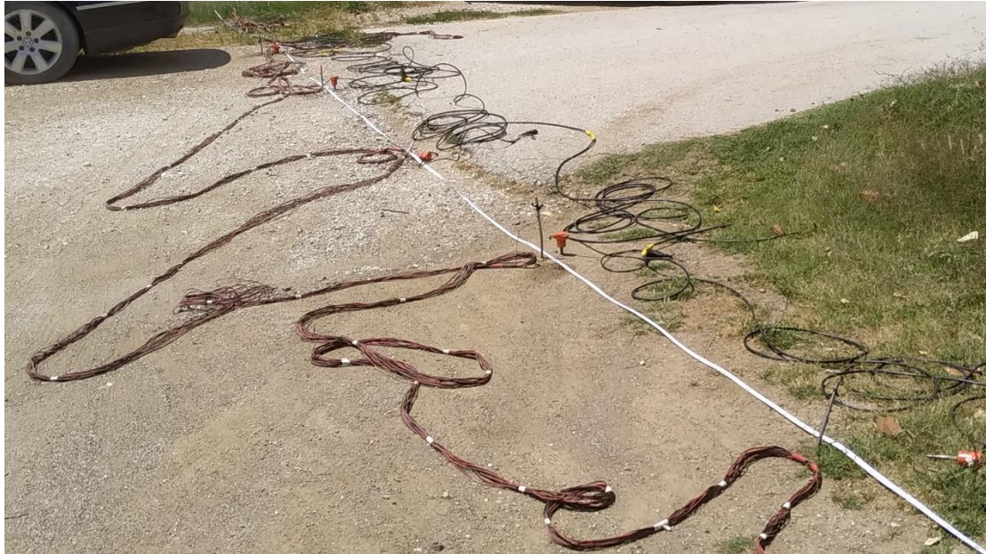
Εικόνα 52: Ατσάλινα ηλεκτρόδια που χρησιμοποιήθηκαν για την εισαγωγή ηλεκτρικού ρεύματος στο έδαφος και τη μέτρηση της διαφοράς δυναμικού που προκαλείται. Φαίνεται επίσης η σύνδεση του πολυπύρηνου καλωδίου, με έξοδο βραχυκυκλωμένη με το κάθε ηλεκτρόδιο.
