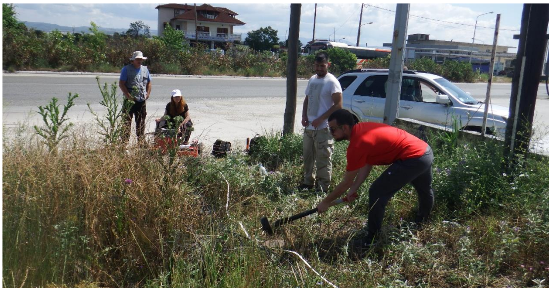
Εικόνα 33: Παραγωγή ελαστικών κυμάτων στην σεισμική γραμμή L1 με χρήση σεισμικής σφύρας. Διακρίνεται και η μεταλλική πλάκα.
