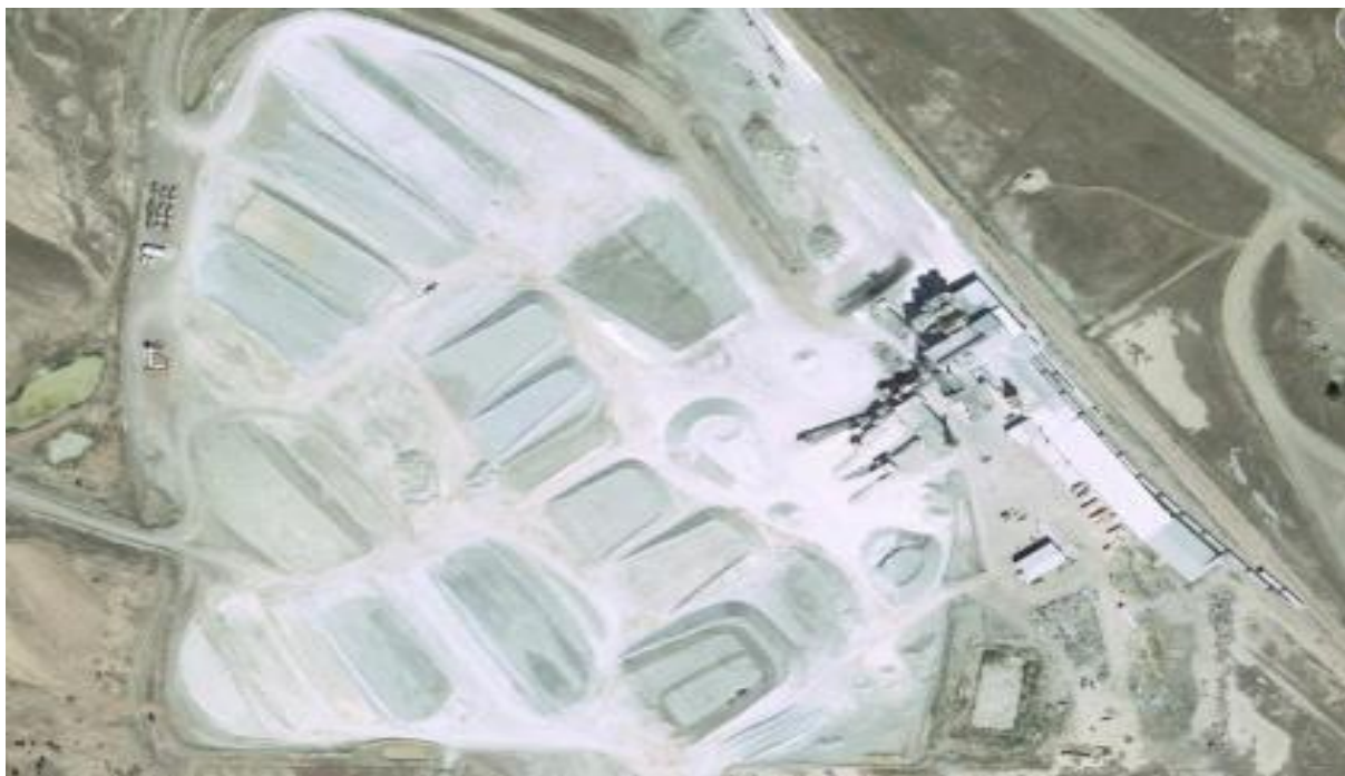
Εικ. 1.2.1: Σοροί μπετονίτη στις πλατείες και σταθμός παραγωγής στο Colony του Wyoming (Πηγή: www.indmin.com ).
