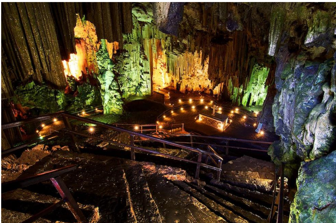
Εικόνα 6. Ο ειδικός διαμορφωμένος διάδρομος με τα ανοξείδωτα κάγκελα. Φαίνεται τόσο ο φωτισμός ασφαλείας κατά μήκος των διαδρόμων όσο και ο φωτισμός ανάδειξης του σπηλαιοδιάκοσμου. ( https://www.melidoni.gr/ ).
