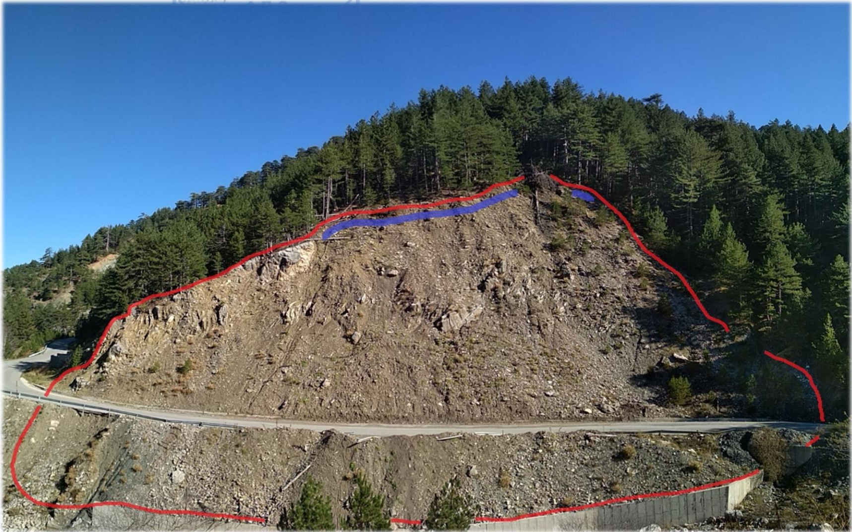
Εικόνα 5.5: Τα όρια της κατολίσθησης με κόκκινο χρώμα. Με μπλε χρώμα διακρίνεται το «φρύδι» της κατολίσθησης.
