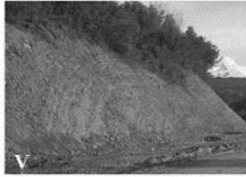
Τύπος V. Μέτρια διαταραγμένη βραχώμαζα αποτελούμενη από ιλυόλιθο με ενστρώσεις ψαμμίτη
