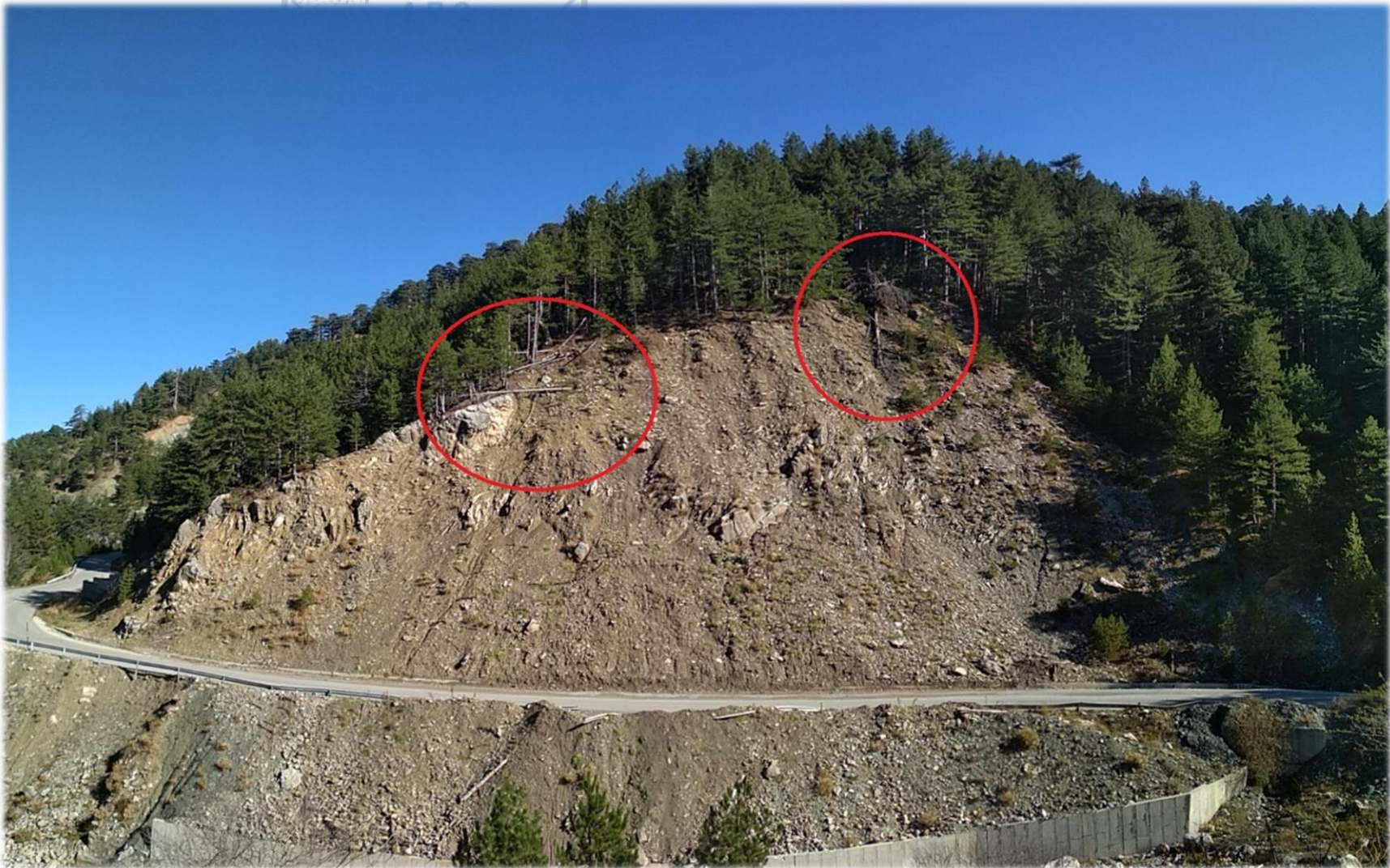
Εικόνα 5.6: Η μεγάλη κάμψη αλλά και η πτώση δέντρων αποτελεί δείκτη ύπαρξης κατολίστησης.
