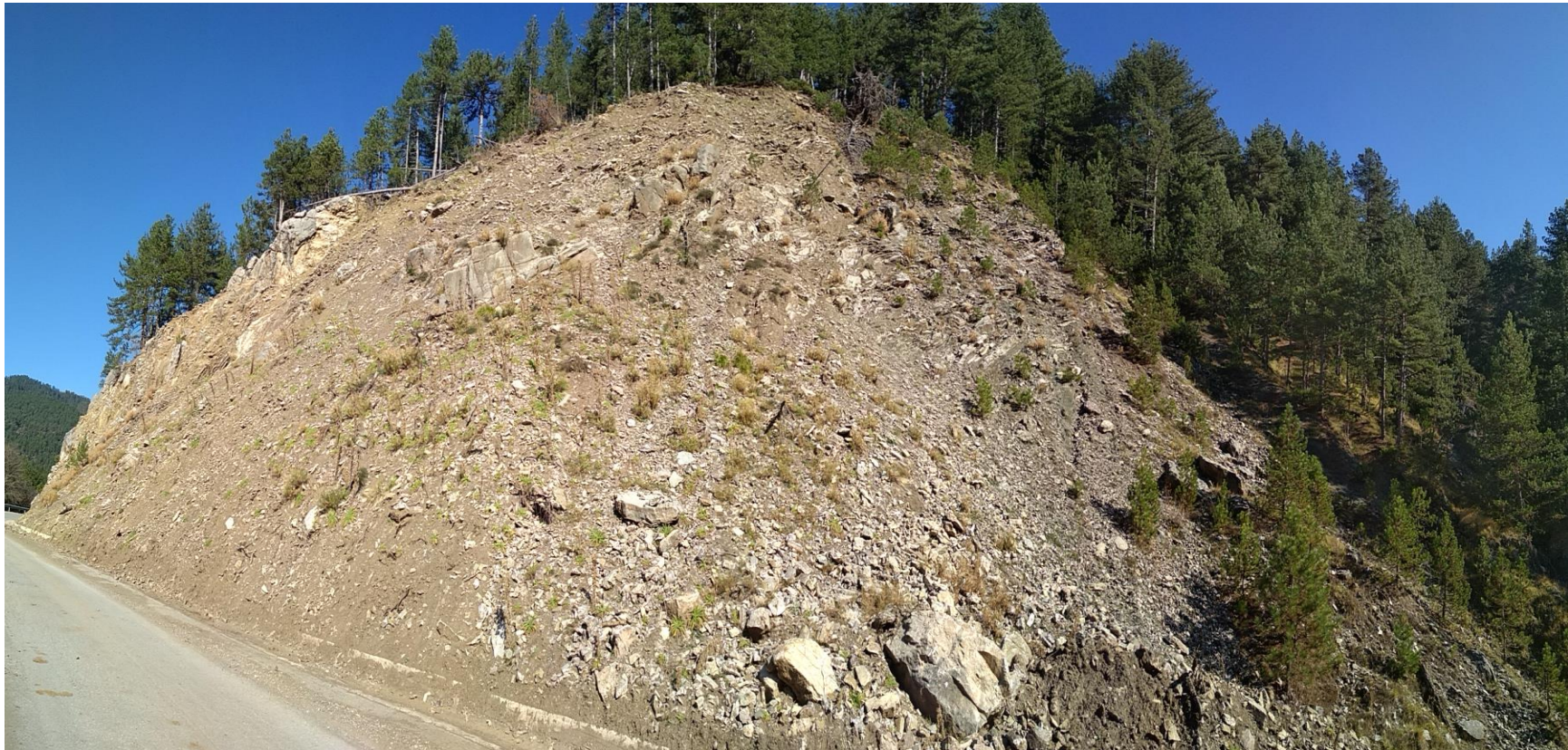
Φωτογραφία 5.1: Πανοραμική λήψη της περιοχής έρευνας. Διακρίνονται στη βάση του πρανούς τα κατολισθέντα υλικά του Σχηματισμού R (ιλυολιθικό υλικό, ασβεστολιθικά και ψαμμιτικά τεμάχια).
