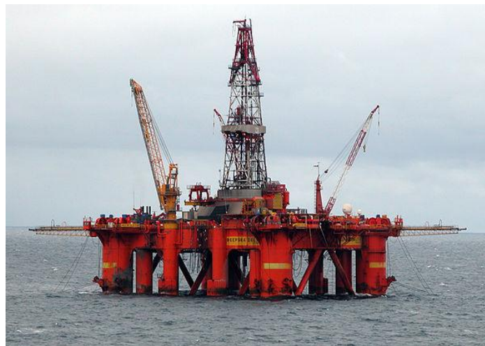
Εικόνα 14 - Semi-Submersible Platform (Ημιβυθιζόμενη πλατφόρμα στη Βόρεια Θάλασσα) [πηγή: https://www.wikiwand.com/ ]
