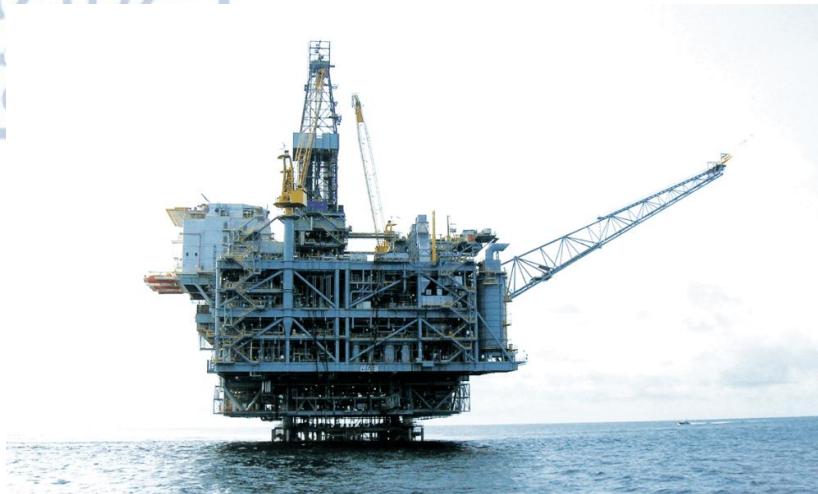
Εικόνα 11 - Compliant Tower (Ο πρώτος συμβατός πύργος στην Αφρική, ανοιχτά της Αγκόλα / υπεράκτια πλατφόρμα γεώτρησης και παραγωγής) [πηγή: https://www.kbr.com/ ]
