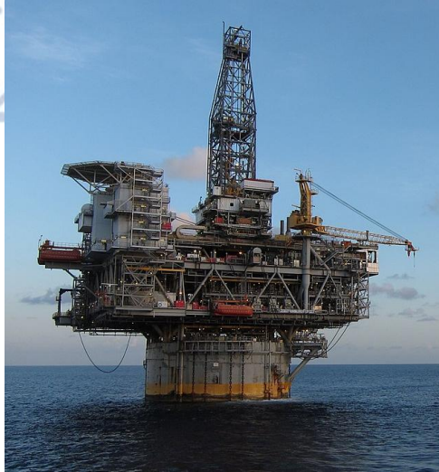
Εικόνα 15 - SPAR (Υπεράκτια πλατφόρμα στον Κόλπο του Μεξικού) [πηγή: https://www.wikiwand.com/ ]
