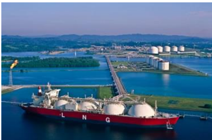
Εικόνα 38 - Μεταφορά LNG σε τερματικό σταθμό [πηγή: https://www.geodifhs.com/ ]
