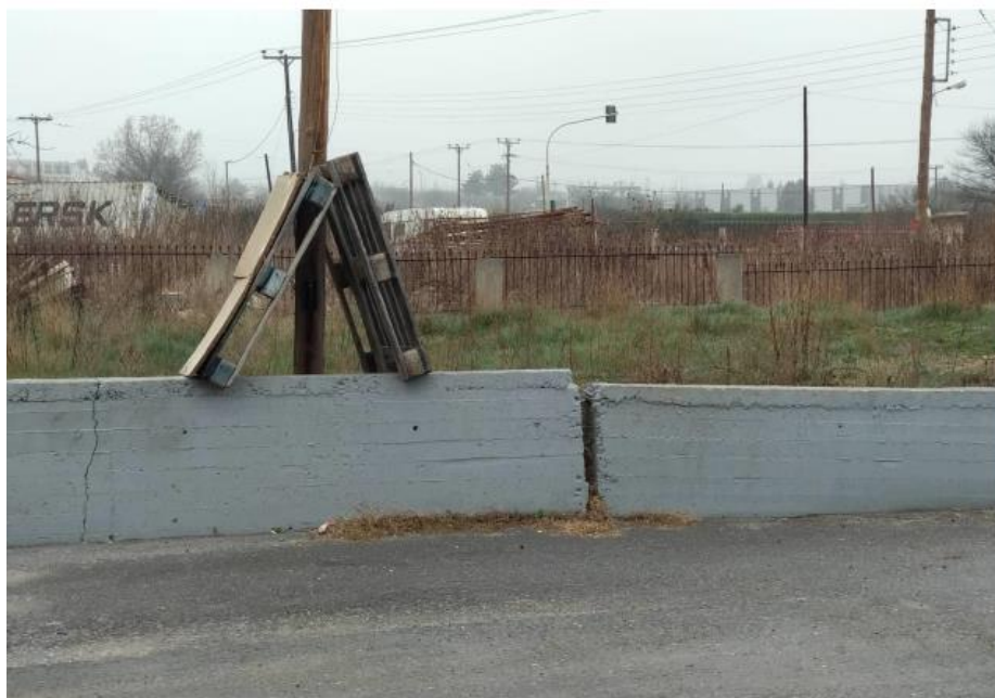
Εικόνα 4. Εμφανής κατακόρυφη και οριζόντια μετατόπιση της τσιμεντένιας περίφραξης στα ΒΔ του καταστήματος «ΕΓΝΑΤΙΑ» (Alexandros Chatzipetros and Evdokia Papadopoulou 2019)
