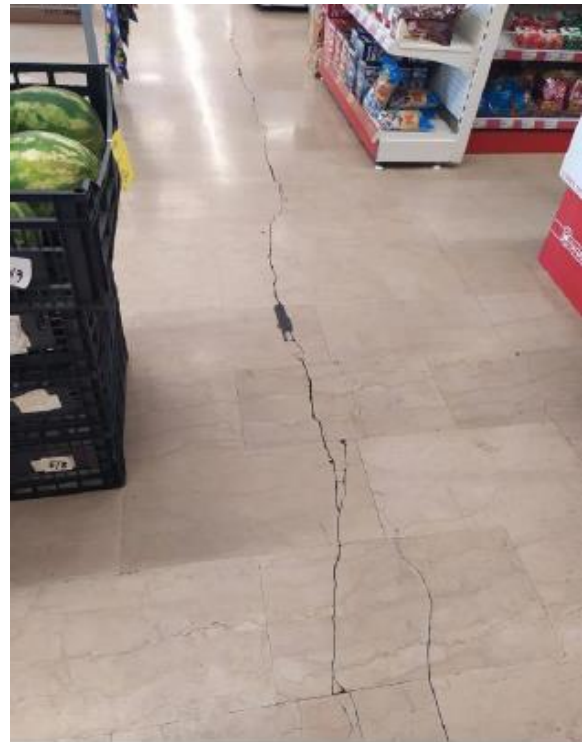
Εικόνα 6. Διάρρηξη στο εσωτερικό του καταστήματος «ΕΓΝΑΤΙΑ».
