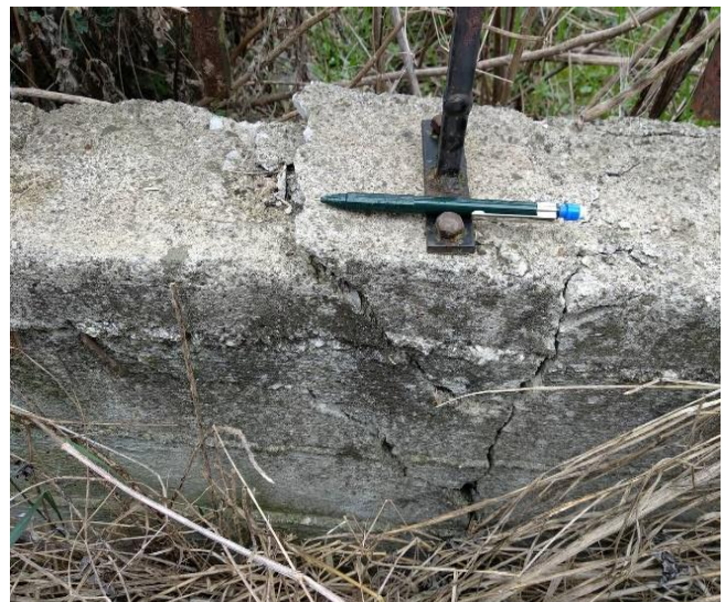
Εικόνα 8. Ψευδοανάστροφο μικρορήγμα σε μικρό τοιχίο 20 μέτρα ανατολικά του καταστήματος «ΕΓΝΑΤΙΑ».
