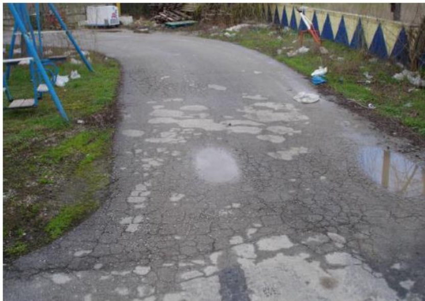
Εικόνα 3. Παρατηρούνται δύο παράλληλες ζώνες διάρρηξης στην ασφαλτο στη ΝΔ πλευρά του καταστήματος «ΕΓΝΑΤΙΑ». Η μια ζώνη φέρει μετάπτωση προς τα ΒΑ, ενώ η άλλη προς τα ΝΔ (Chatzipetros et al., 2005)
