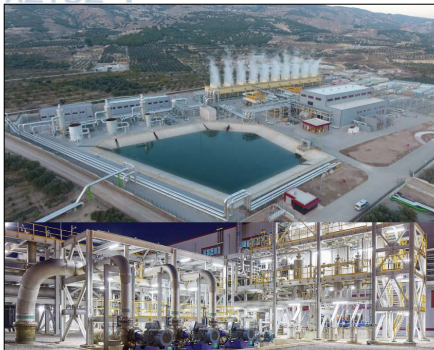
Εικόνα 52: Γεωθερμικές μονάδες ηλεκτροπαραγωγής στο Kizildere ( www.zorluenerji.com )
