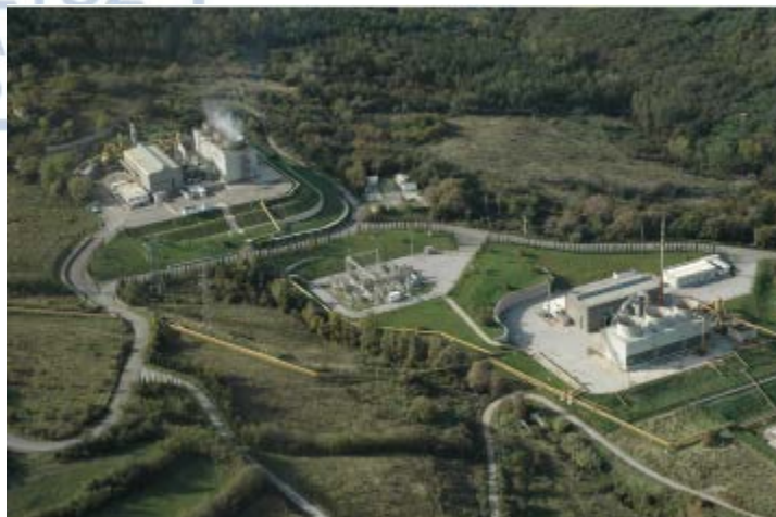
Εικόνα 24: Οι μονάδες παραγωγής ενέργειας Piancastagnaio 4 και 5, στην περιοχή Monte Amiata (Cappetti et al., 2010)
