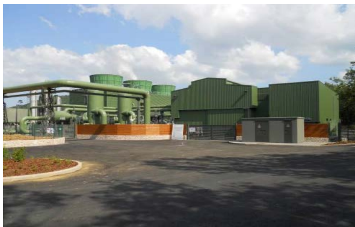
Εικόνα 26: Ο σταθμός ηλεκτροπαραγωγής Chiusdino 1 στην περιοχή Travale-Radicondoli της Ιταλίας (Bonciani et al., 2013)
