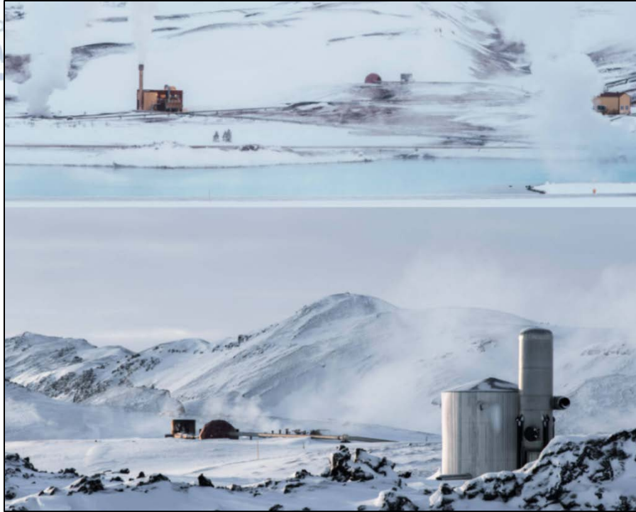
Εικόνα 44: Η γεωθερμική μονάδα ηλεκτροπαραγωγής Bjarnaflag, Ισλανδία ( www.northlandscapes.com )
