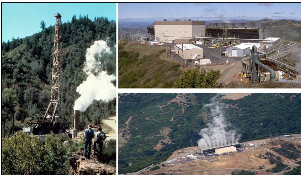
Εικόνα 4: Γεωθερμικό πεδίο The Geysers (ΗΠΑ). Κατασκευή γεωθερμικής γεώτρησης το 1977(αριστερά)-Γεωθερμικές μονάδες ξηρού ατμού(δεξιά) (πηγές: www.wikipedia.org ; www.marlimillerphoto.com )
