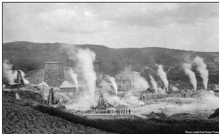
Εικόνα 17: Κατασκευή των πρώτων γεωθερμικών ηλεκτροπαραγωγικών μονάδων στο πεδίο Larderello, Ιταλία(www.enel.it)
