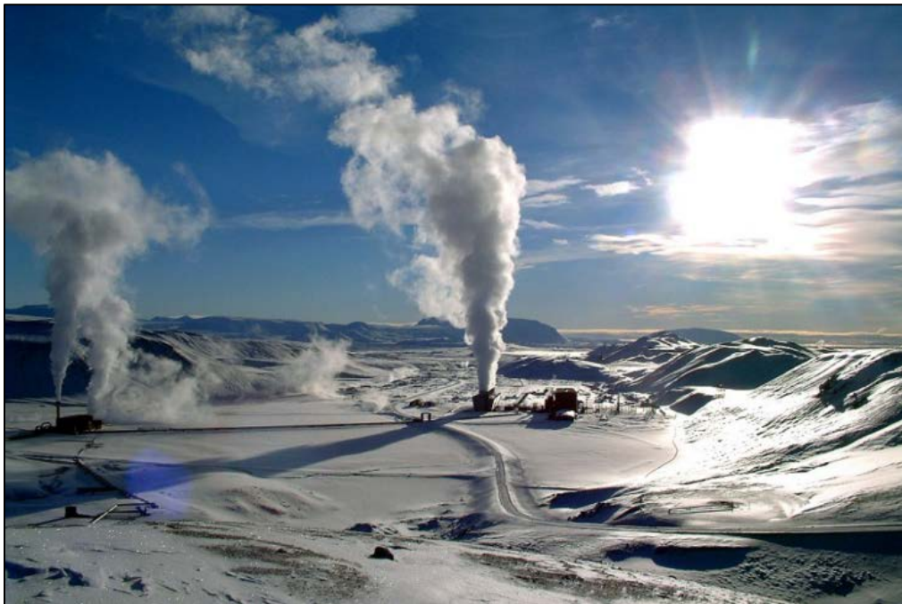
Εικόνα 45: Η γεωθερμική μονάδα Krafla ( www.nsenergybusiness.com )
