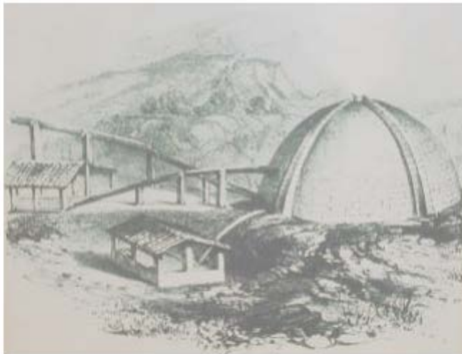
Εικόνα 28: Η "Σκεπαστή λίμνη" (Covered Lagoon) στο Larderello για την συλλογή του βορικού οξέος από τα γεωθερμικά ρευστά (Dickson and Fanelli, 2004; www.web.mit.edu )
