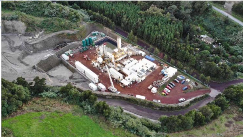
Εικόνα 34: Κατασκευή νέων γεωθερμικών γεωτρήσεων στα νησιά των Αζόρων, Πορτογαλία ( www.thinkgeoenergy.com )
