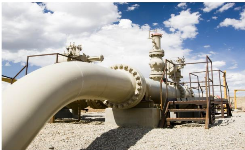
Εικόνα 20: Αγωγός μεταφοράς \text{CO}_2 στο Wyoming των Η.Π.Α ( https://www.club-co2.fr/en/content/co2-transport ).
