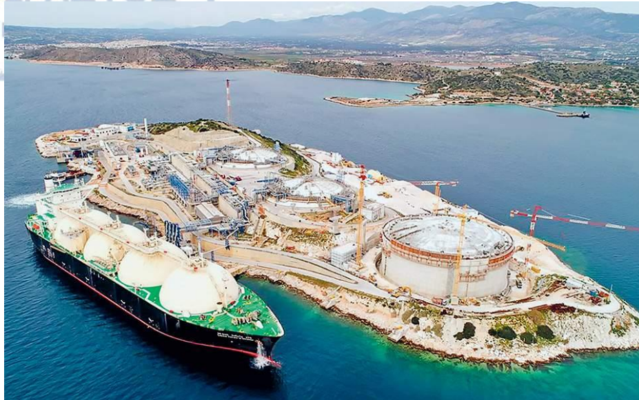
Εικόνα 4: Τερματικός σταθμός Υγροποιημένου Φυσικού Αερίου - ΥΦΑ (LNG) στη Ρεβυθούσα
