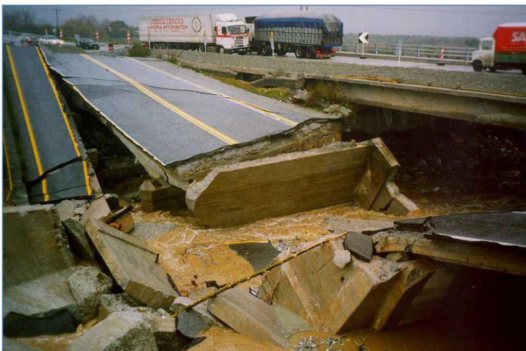
Φώτο 9. 1 Κατάρρευση Γέφυρας στην Εθνική Οδό Αθηνών – Θεσ/νίκης, στο χείμαρρο Ζηλιάνα, κοντά στον Πλαταμώνα Πιερίας - Νοέμβριος 1998 (URL11).
