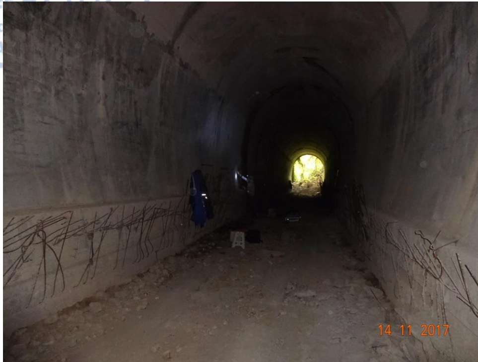
Σχήμα 5.1 Περιοχή μελέτης, πάνω η είσοδος στη σήραγγα, κάτω χαρακτηριστική εικόνα του εσωτερικού της σήραγγας.
