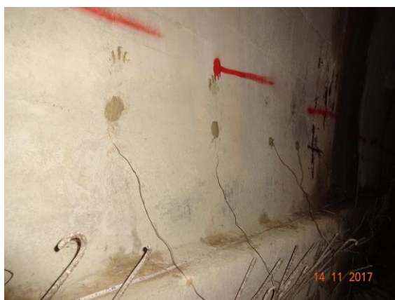
Σχήμα 5.8 Απεικόνιση της επιφανειακής υγρασίας στο τοιχίο της σήραγγας.
