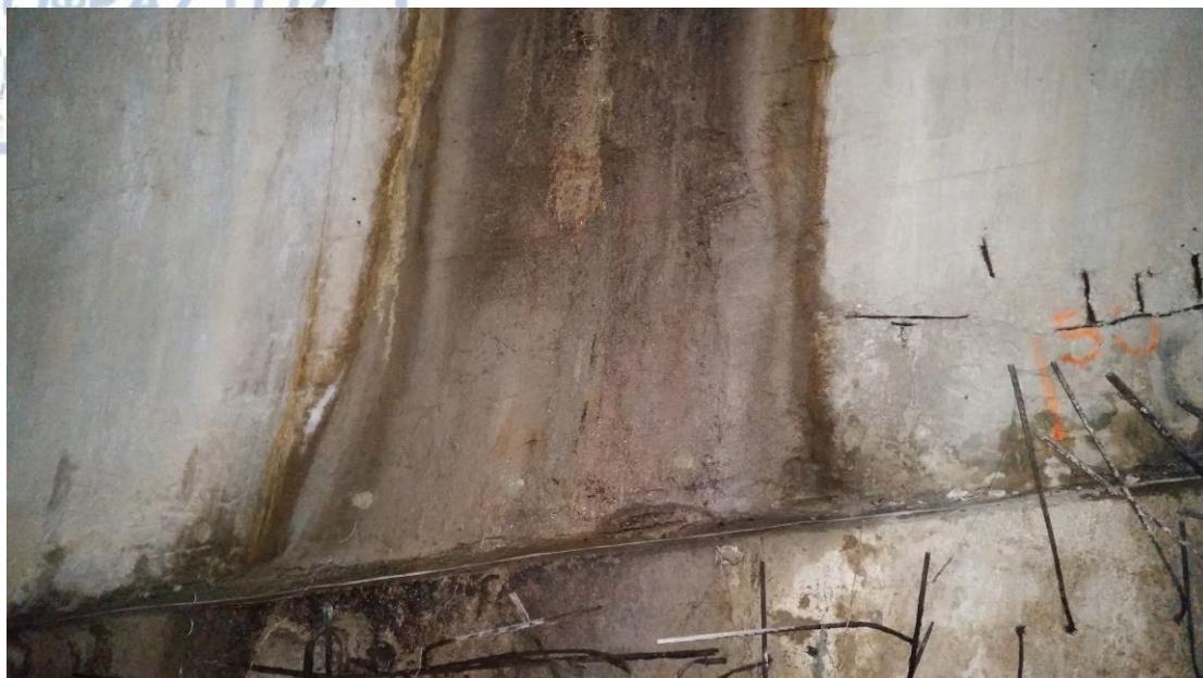
Σχήμα 5.8 Απεικόνιση της επιφανειακής υγρασίας στο τοιχίο της σήραγγας.
