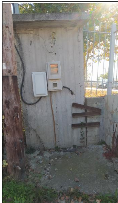
Εικόνα 11. Εικόνα της αποκόλλησης του τοιχίου της περίφραξης
