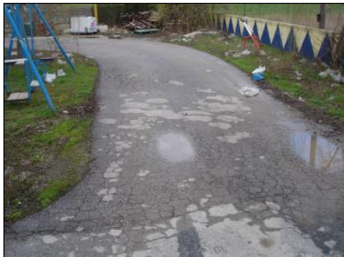
Εικόνα 3. Δύο παράλληλες ζώνες διάρρηξης στη Βορειοδυτική πλευρά του supermarket (Chatzipetros et.al 2005)
