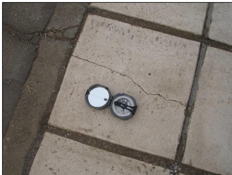
Εικόνα 7. Δευτερεύουσα Διάρρηξη σε πλακόστρωση πεζοδρομίου (Chatzipetros et.al 2005)
