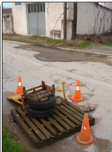
Εικόνα 9. Παραμόρφωση σε αποθήκη και στην ασφαλτόστρωση του δρόμου (Chatzipetros et al..2005)
