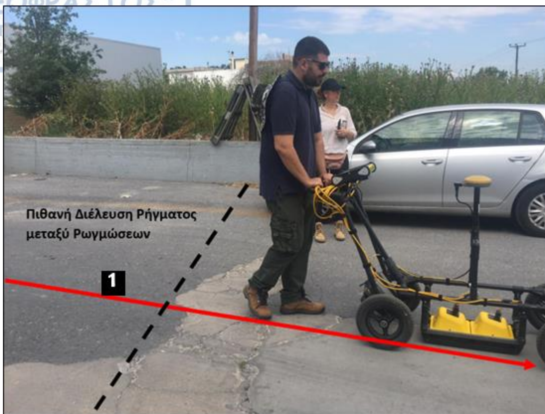
Εικόνα 171. Διέλευση γεωραντάρ για εξακρίβωση της συνέχειας της ρωγμής
