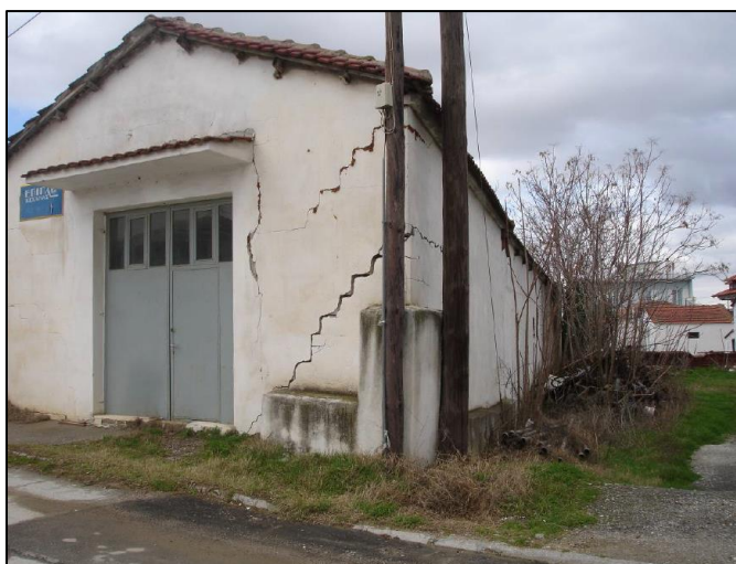
Εικόνα 9. Παραμόρφωση σε αποθήκη και στην ασφαλτόστρωση του δρόμου (Chatzipetros et al..2005)
