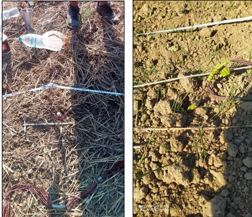
Εικόνα 72. Η σύνδεση των ηλεκτροδίων με το πολύκλωνο καλώδιο μέσω της εξόδου
