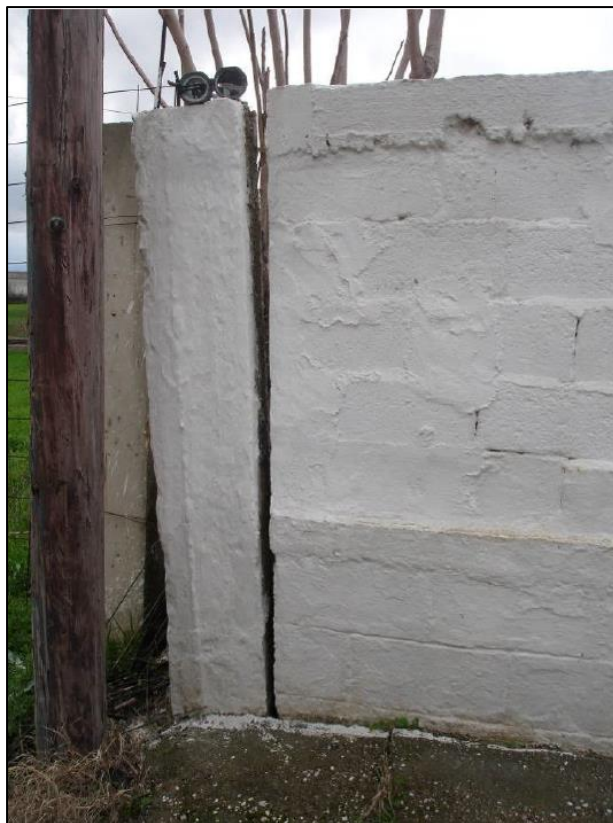
Εικόνα 8. Αποκόλληση κολώνας σε φράχτη (Chatzipetros et al.2005)
