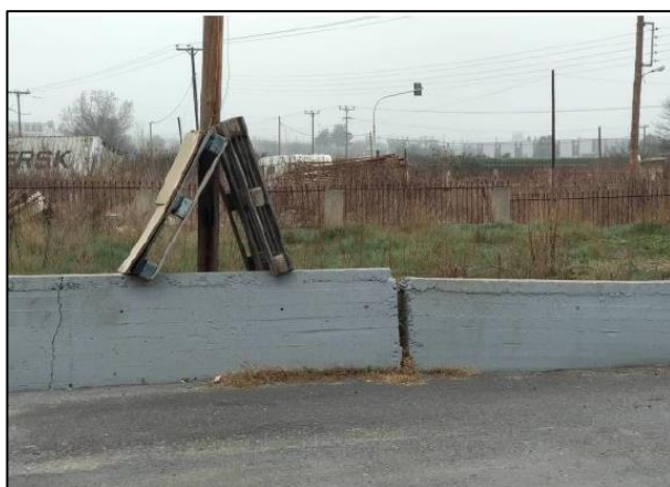
Εικόνα 168. Οι φθορές που οφείλονται στην εμφάνιση του φαινομένου των εδαφικών ρωγμών
