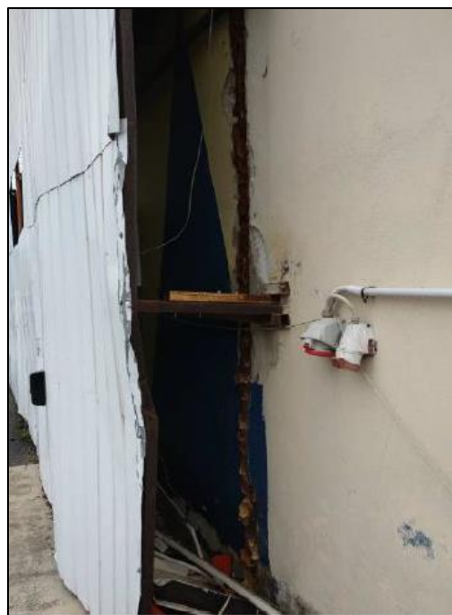
Εικόνα 168. Οι φθορές που οφείλονται στην εμφάνιση του φαινομένου των εδαφικών ρωγμών
