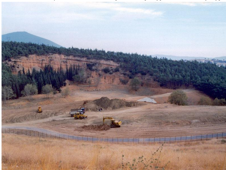
Σχήμα 5: Διαδικασίες αποκατάστασης της περιοχής που λειτουργούσε η χωματερή(Πηγή Υδροφίλη Α.Ε.)
