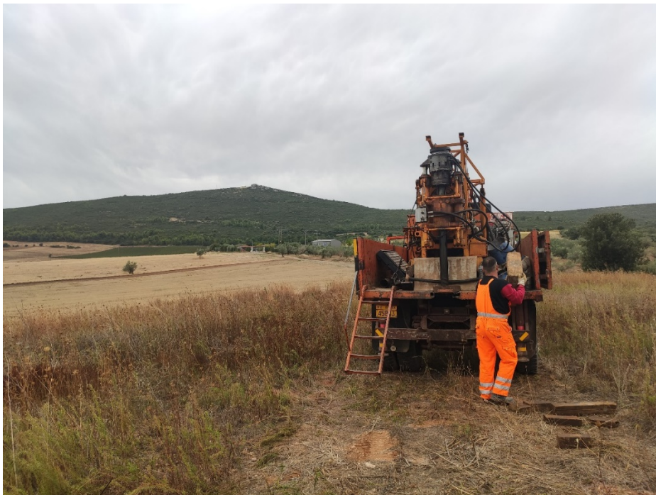
Εικόνα 13: Εγκατάσταση Γεωτρητικού Εξοπλισμού
