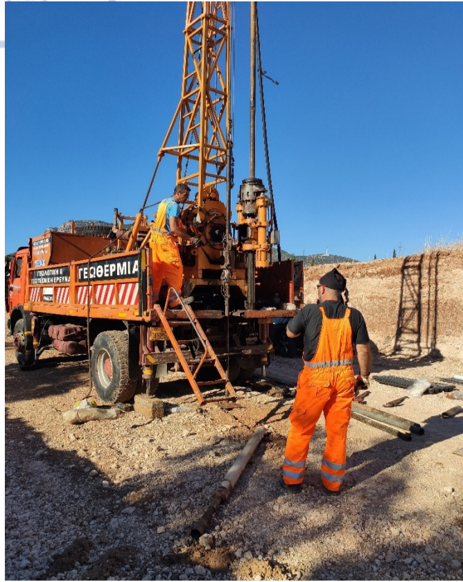
Εικόνα 19: Εγκατάσταση Γεωτρητικού Έξοπλισμού
