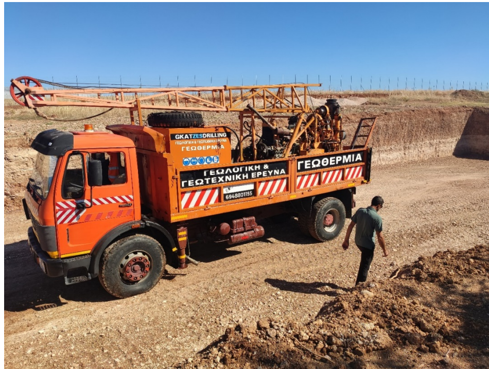
Εικόνα 18: Εγκατάσταση Γεωτρητικού εξοπλισμού
