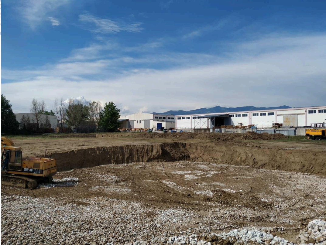
Εικόνα 82: Εκσκαφή μέχρι την στάθμη του υδροφόρου
