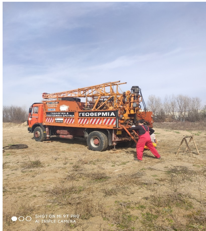
Εικόνα 20: Εγκατάσταση Γεωτρητικού Εξοπλισμού
