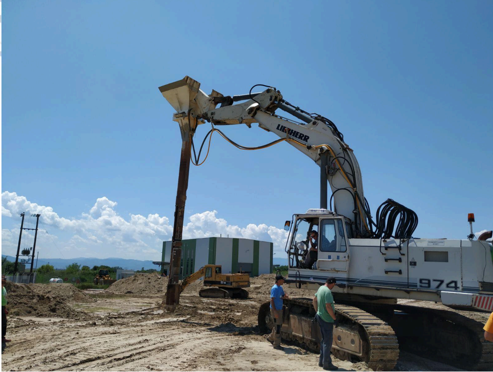
Εικόνα 84: Τοποθέτηση χαλικοπάσσαλων ως μέτρο βελτίωσης εδάφους
