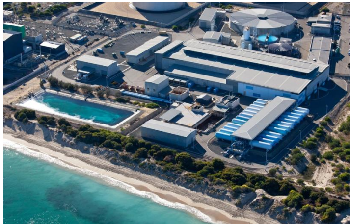
Σχήμα 2: Μονάδα αφαλάτωσης θαλασσινού νερού για την κάλυψη των αναγκών ύδρευσης στο Περθ της Αυστραλίας. Πηγή: https://www.suezwaterhandbook.com/
