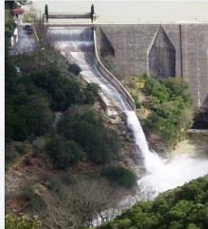
Εικ.7. Κατά μήκος τομή του μεγάλου υπερχειλιστή του φράγματος Λάδωνα και μερική λειτουργία του, Δ. Δημόπουλος & Ι.Π. Στεφανάκος (2008).
