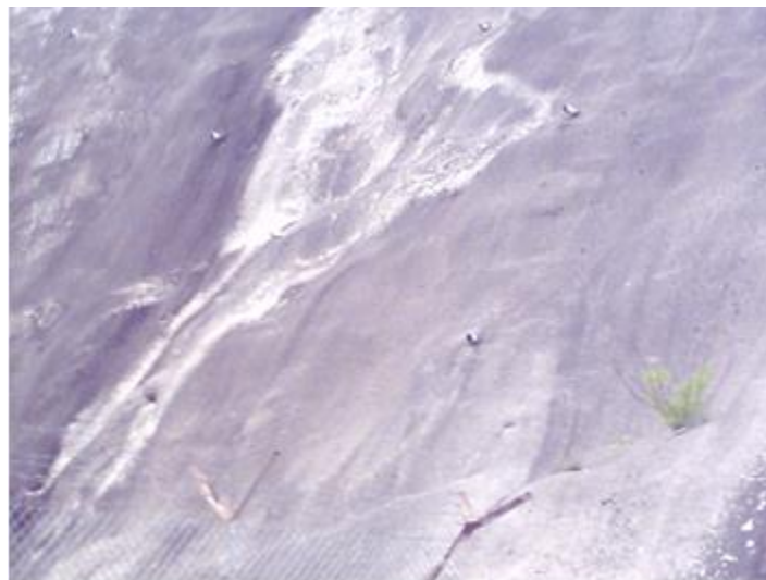
Εικ.19. Οπές αποστράγγισης και εκτοξευόμενο σκυρόδεμα στο αριστερό αντέρεισμα του φράγματος.
