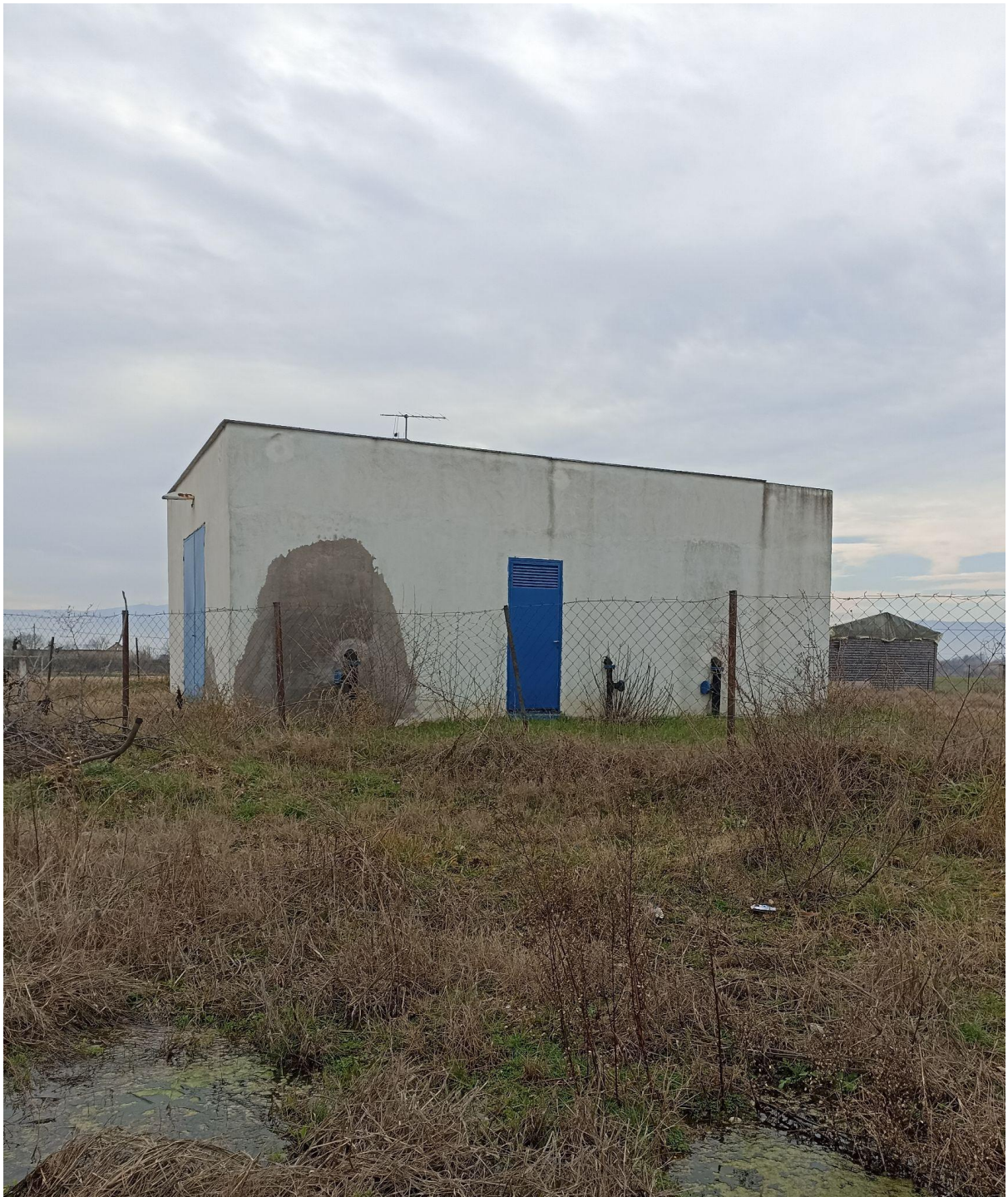
Σχήμα 4.7: Γεώτρηση περιοχή γήπεδο πίσω στο Λαγκαδά (περιέχει δύο γεωτρήσεις).
