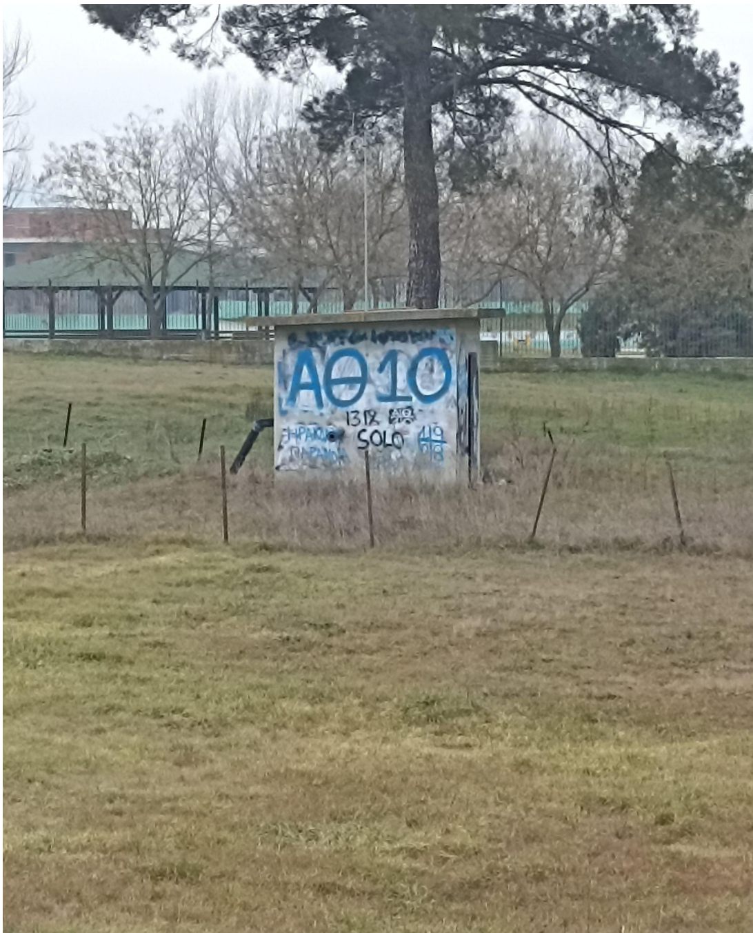
Σχήμα 4.8: Γεώτρηση δίπλα στον ποταμό Μπογδάνα στην περιοχή του Λαγκαδά.
