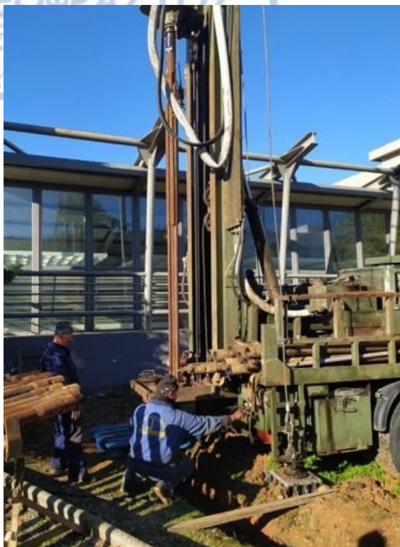
Εικόνα 9: Εγκατάσταση γεωτρύπανου και περιβάλλον χώρος εργασιών
