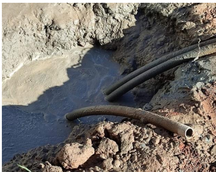
Εικόνα 10: Πλήρωση της γεώτρησης με θερμοαγώγιμο ένεμα
