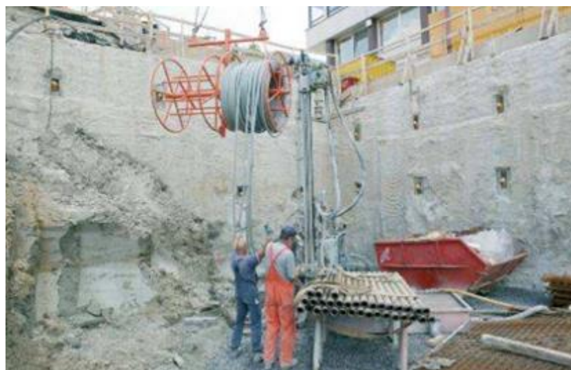
Εικόνα 2: Εισαγωγή γεωεναλλάκτη σε γεώτρηση σε θεμέλια κτιρίου ( www.rehau.de )
