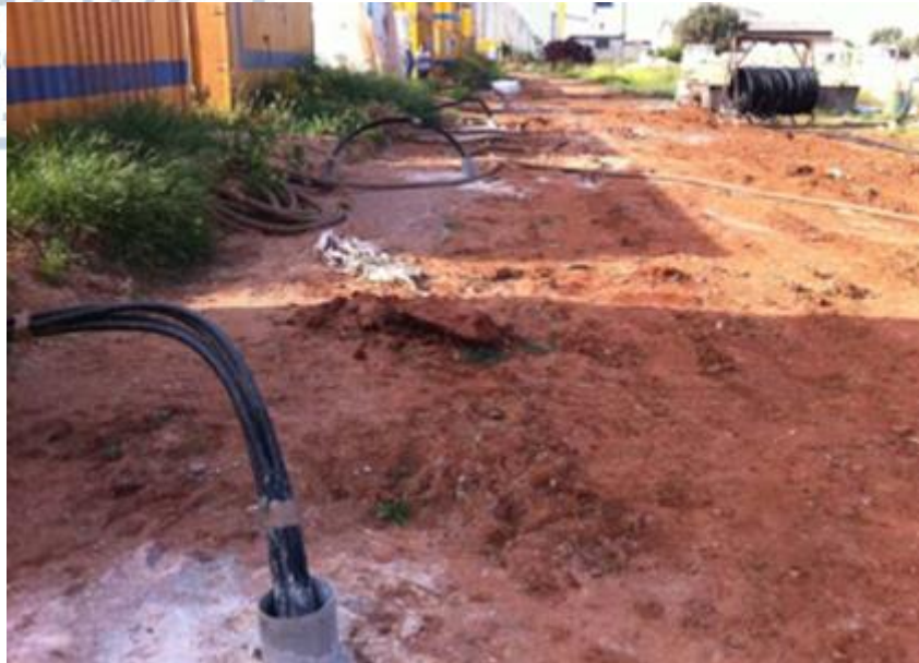
Εικόνα 3: Διαδοχικές γεωτρήσεις για την τοποθέτηση κατακόρυφου γεωεναλλάκτη ( www.rehau.de )
