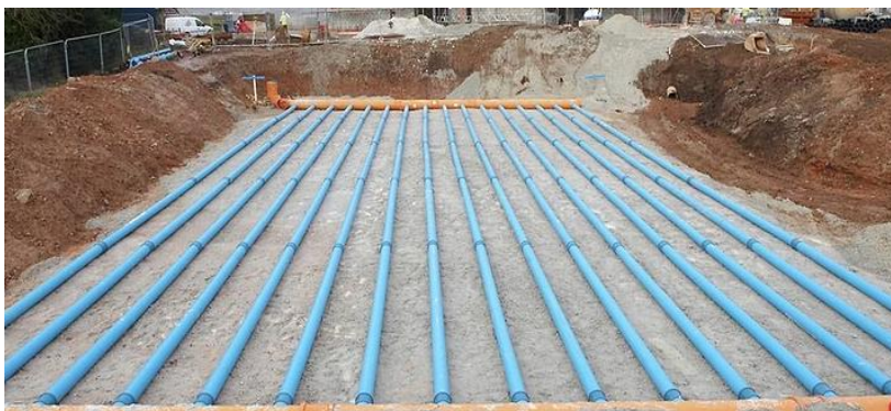
Εικόνα 1: Σωληνώσεις οριζόντιου γεωεναλλάκτη ( www.nikolaospsarras.com )
