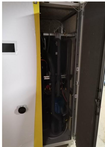
Εικόνα 14: Αντλία θερμότητας στο κτίριο Υδραυλικής του ΑΠΘ
