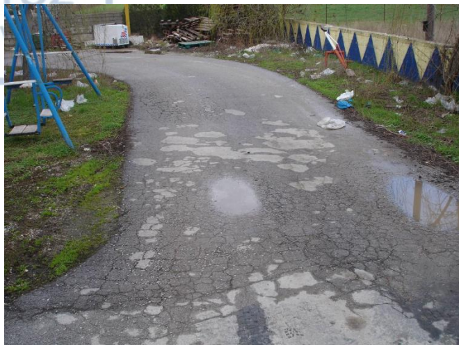
Εικόνα 2. Οι δύο παράλληλες ζώνες διαρρήξεων στην ασφαλτο στη ΒΔ πλευρά του καταστήματος "ΕΓΝΑΤΙΑ".
