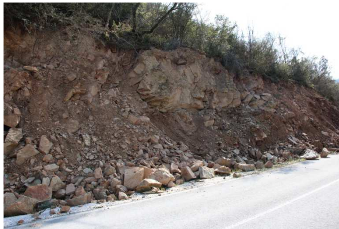
Σχήμα 5-6. Κατολίσθηση πλαγιάς επαρχιακής οδού στο Βλαχογιάννη.
