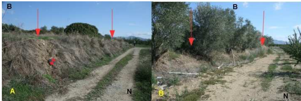
Σχήμα 7-47. Α Φωτογραφία υπαίθρου περιοχής σχήματος 7-45, όπου διακρίνονται οι ρηξιγενείς επιφάνειες (Scarp 5). Και στο Β η επιφάνεια ρηξιγενής επιφάνεια (Scarp 6)
