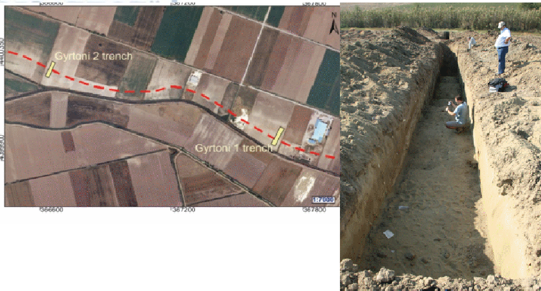
Σχήμα 7-100. Αριστερή εικόνα: η θέση των παλαιοσεισμολογικών τομών κίτρινο πολύγωνο και με την κόκκινη γραμμή το ρήγμα της Γυρτώνης (Tsodoulos et al 2016) τροποποιημένο, ενώ στην δεξιά εικόνα εργασίες εκτέλεσης εκσκαφών της πρώτης παλαιοσεισμολογικής τομής.
