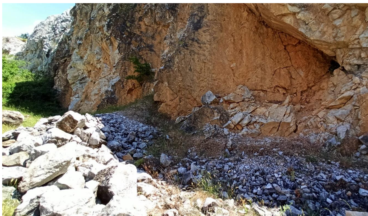
Εικόνα 3.46 Τεχνικογεωλογική ενότητα 4: Τα τεμάχια που βρέθηκαν στο πόδα του πρανούς.
