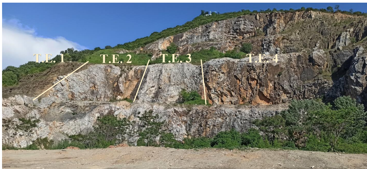
Εικόνα 3.20 Διαχωρισμός του πρανούς σε τεχνικογεωλογικές ενότητες.
