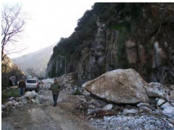
Εικόνα 1.15 Βραχοκαταπτώσεις στη περιοχή των Τεμπών. 17/12/2009 (Η. Saroglou, 2013)
