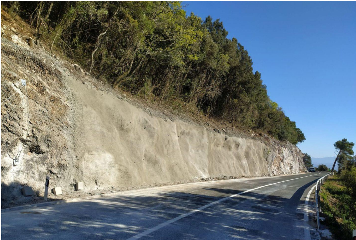
Εικόνα 2.17 Εφαρμογή εκτοξευμένου σκυροδέματος σε βραχώδες πρανές. (Πηγή: geotech )
