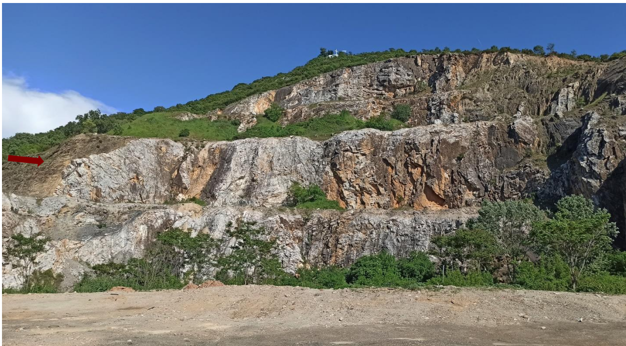
Εικόνα 3.19 Το πεδίο εργασίας. Το πρανές που μελετήθηκε είναι αυτό που επισημαίνεται με βέλος ανάμεσα στις δύο αναβαθμίδες με γενική διεύθυνση πρανούς BBΔ-NNA, διεύθυνση κλίσης από 242° έως 275° και γωνία κλίσης 80°.
