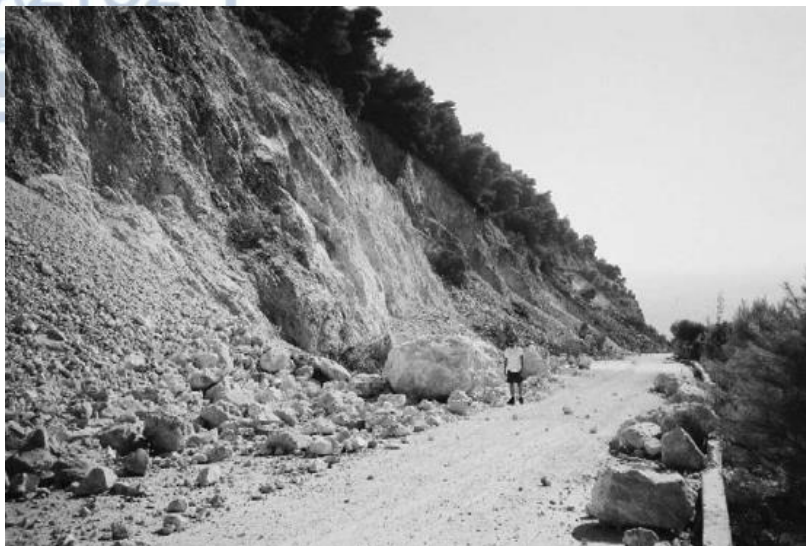
Εικόνα 1.17 Βραχοκατάπτωση στη περιοχή της Λευκάδας, έπειτα από σεισμό μεγέθους M_s=6,2 . 14/8/2003. (G Papathanassiou, Pavlides, & Ganas, 2005)
