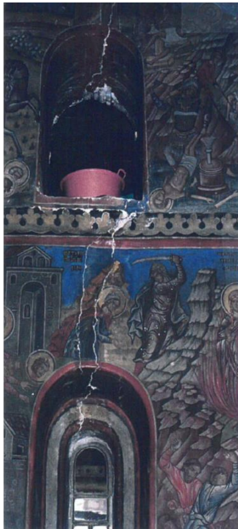
Εικόνα 8: Εμφανείς έντονες ρηγματώσεις στο τμήμα της Λιτής τόσο στο εξωτερικό και στο εσωτερικό του Ναού.
