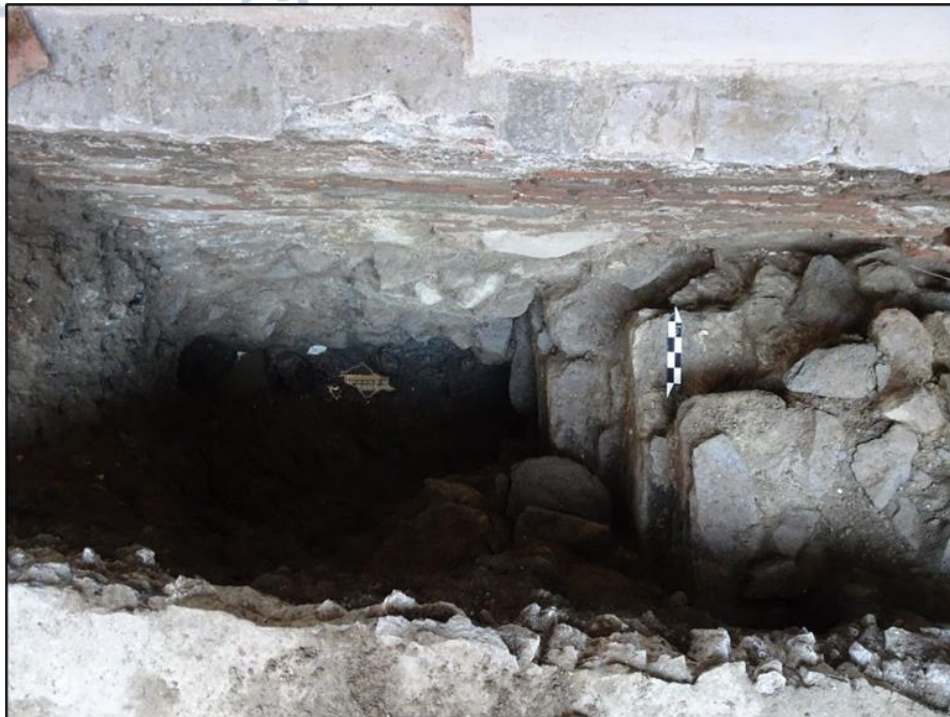
Εικόνα 58: Ξυλοπάσσαλοι στη δυτική προέκταση της θεμελίωσης από το σκάμμα έρευνας
