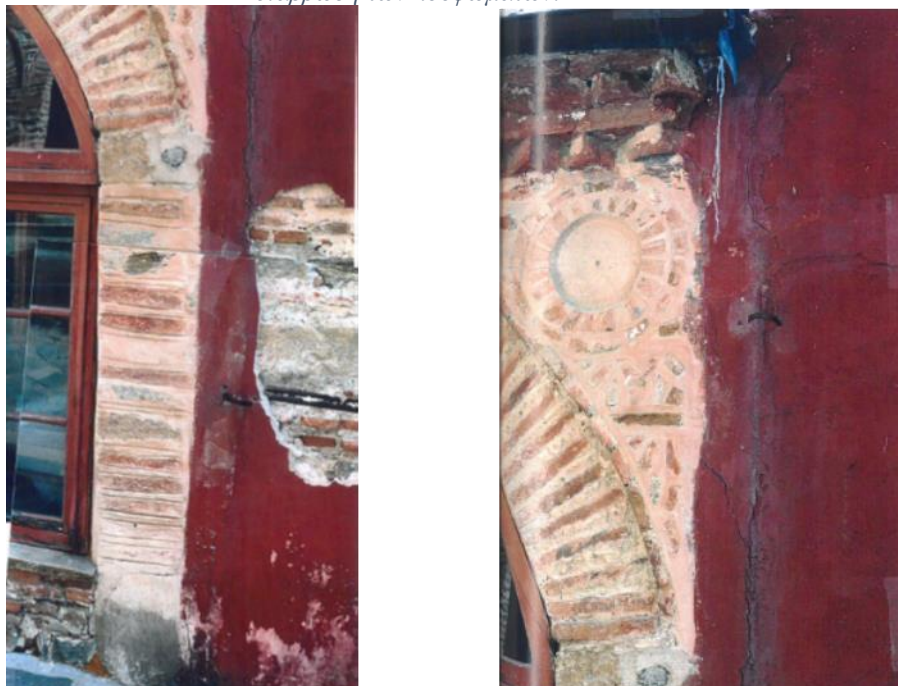
Εικόνα 4: Παρατηρούμε το σημείο ένωσης του Εζωνάρθηκα με κομμάτι της Λιτής. Ο διαφορετικός τρόπος δόμησης των δύο στοιχείων είναι διακριτός.
