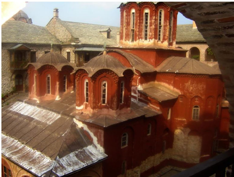
Εικόνα 6: Σύστημα στέγασης Λιτής. Είναι εμφανής οι διαμορφωμένες επιφάνειες απορροής όμβριων υδάτων.
