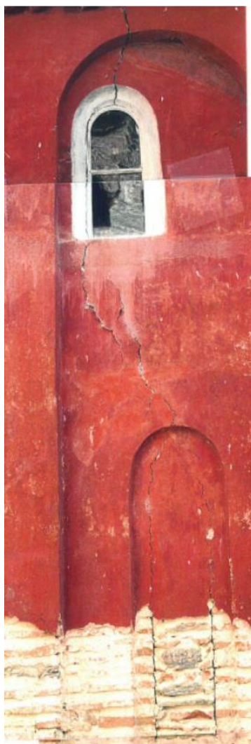
Εικόνα 8: Εμφανείς έντονες ρηγματώσεις στο τμήμα της Λιτής τόσο στο εξωτερικό και στο εσωτερικό του Ναού.
