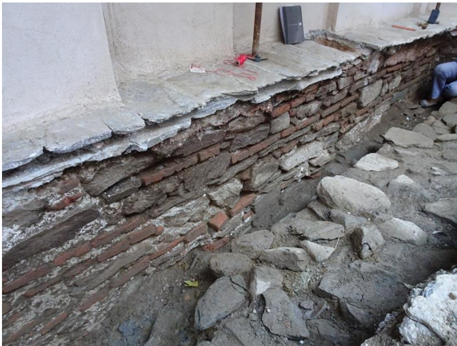
Εικόνα 57: Διάταξη θεμελίωσης Καθολικού Ι.Μ. Κουτλουμουσίου
