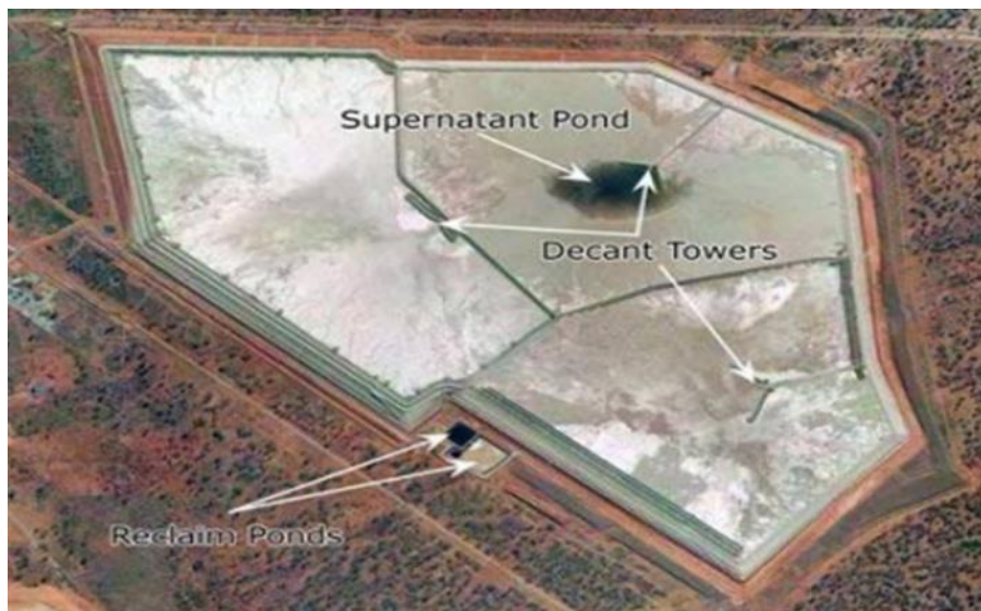
Εικόνα 4.2: Φράγμα σε μορφή δαχτυλιδιού, Western Australia ( https://www.tailings.info/storage/containment.htm )
