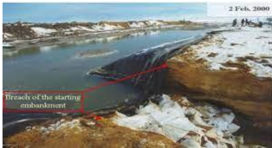
Εικόνα 3.1: Κατάρρευση φράγματος Aznalcollar, Spain, Εικόνα 3.2: Κατάρρευση φράγματος Baia Mare, Romania
