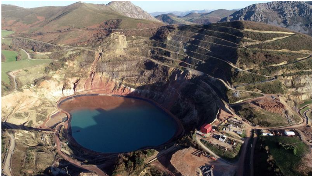
Εικόνα 4.3: Φράγμα σε επιφανειακό όρυγμα μεταλλείου, El Valle, Asturias, Spain ( https://www.mindat.org/loc-106025.html )
