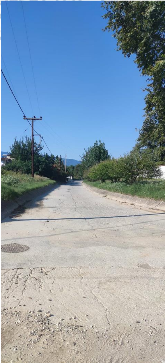
Εικόνα 30: Ασφαλτόστρωση της κοίτης του Χειμάρρου 4.
