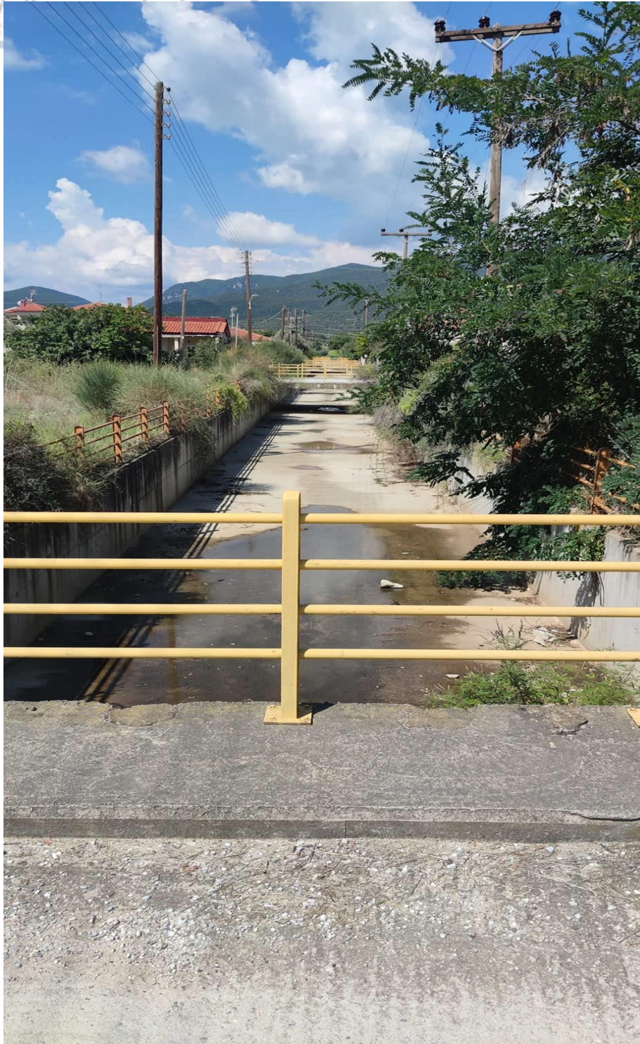
Εικόνα 34: Γέφυρα κατά μήκος της ροής του χειμάρρου Βρασών.
