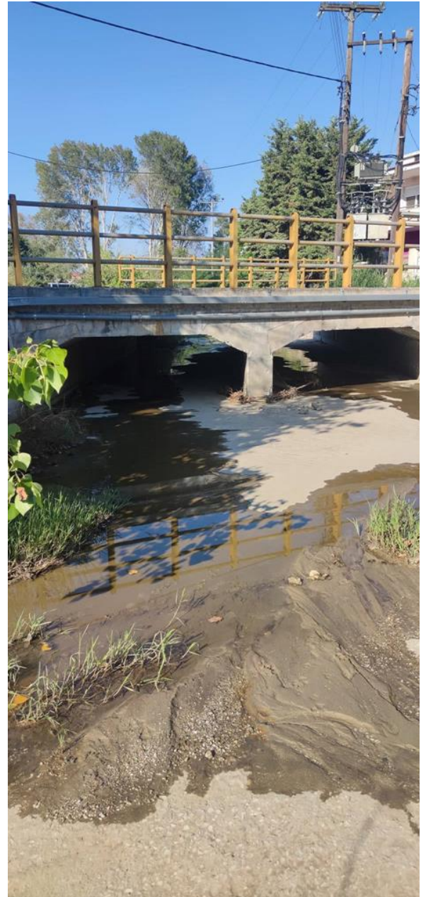
Εικόνα 31: Γέφυρα στον Χειμάρρο 4 που εξυπηρετεί το κεντρικό οδικό δίκτυο.
