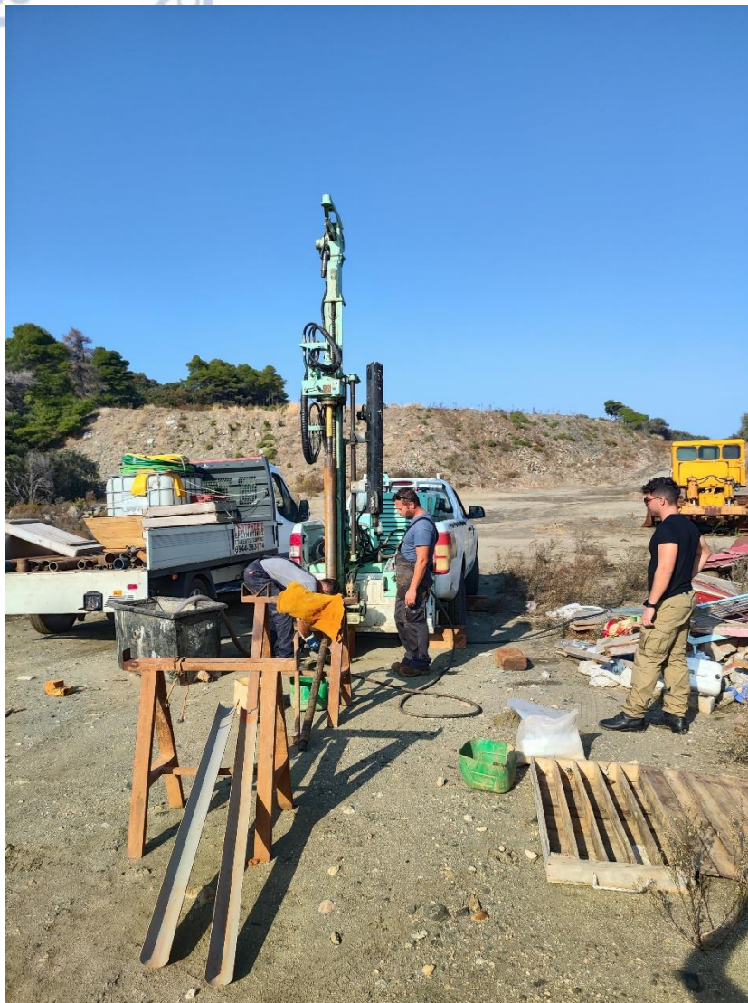
Εικόνα 12: Εκτέλεση της δειγματοληπτικής γεώτρησης Γ3 στη θέση του έργου
