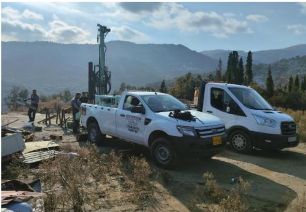
Εικόνα 11: Εκτέλεση της δειγματοληπτικής γεώτρησης Γ1 στη θέση του έργου
