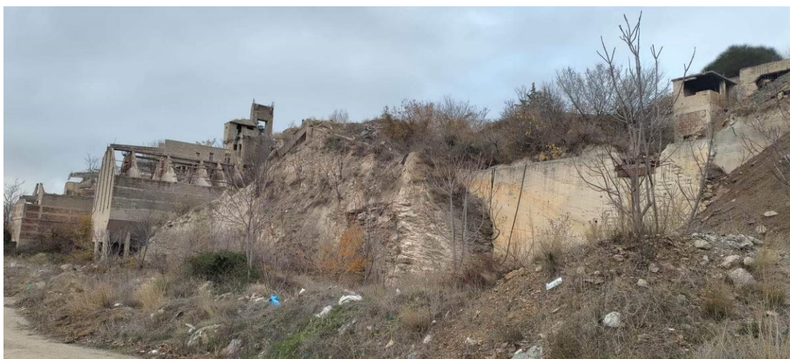
Εικόνα 11.25 Παλιοί σπαστήρες ασβεστίτη -ασβεστόλιθου
