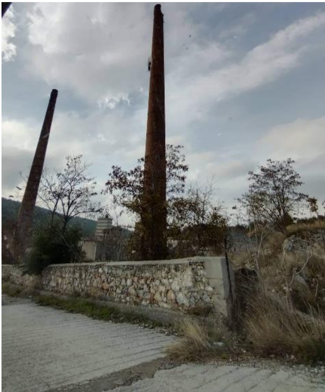
Εικόνα 11.1 Παλιοί Ασβεστοκάμινοι για καύση Ασβεστόλιθου, η παρουσία του ασβεστόλιθου στην περιοχή είναι αιτία της ονοματοδοσίας της περιοχής
