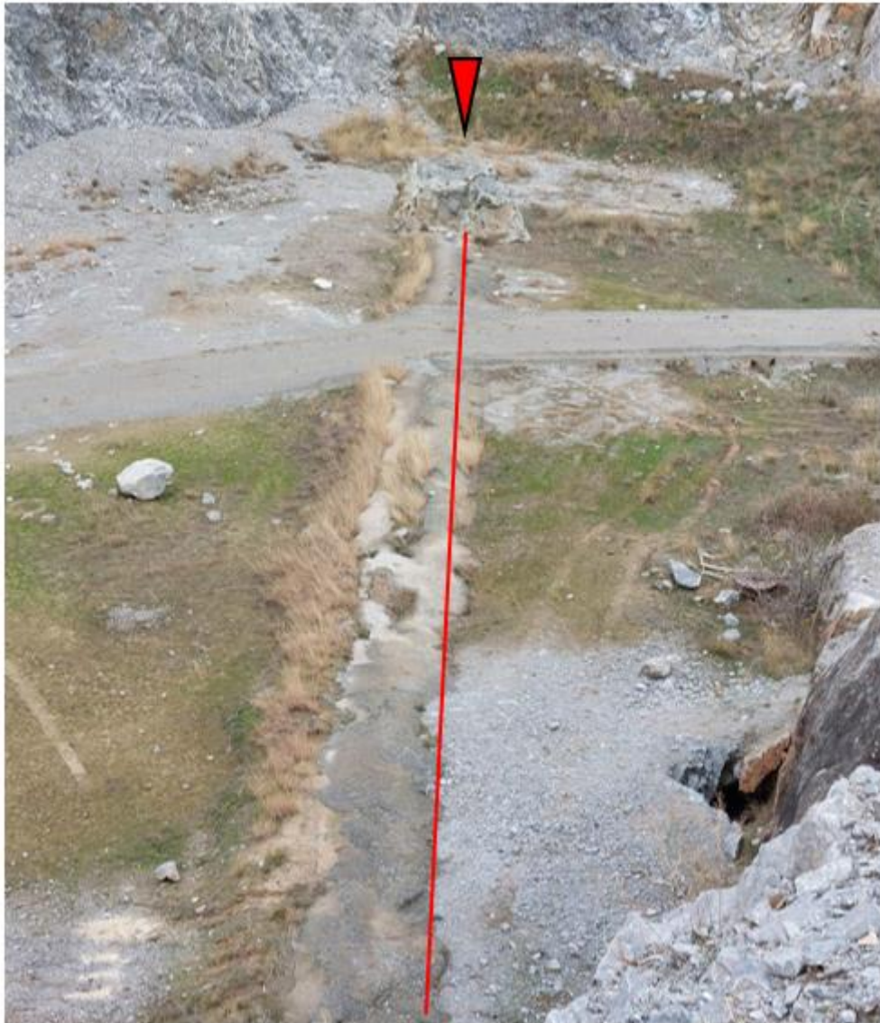
Εικόνα 11.15 Γεώτρηση Λατώ (Κόκκινο τρίγωνο) και Αγωγός μεταφοράς νερού από την γεώτρηση Λατώ στη δεξαμενή Λατώ.
