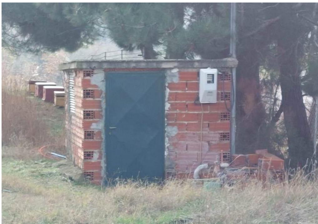
Εικόνα 11.18 Γεώτρηση Σφαγείο - Κλεόβουλος
