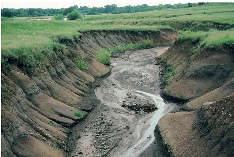
Εικόνα 1.6: Διάβρωση λόγω νερού σε περιοχές με κλίμα Humid (ΠΗΓΗ: https://www.sciencesource.com/archive/Image/Water-Erosion-SS2201007.html )
