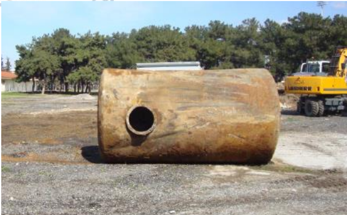
Εικόνα 4.2.6 Η δεξαμενή Δ2 αφού πραγματοποιήθηκε η εκταφή της.
