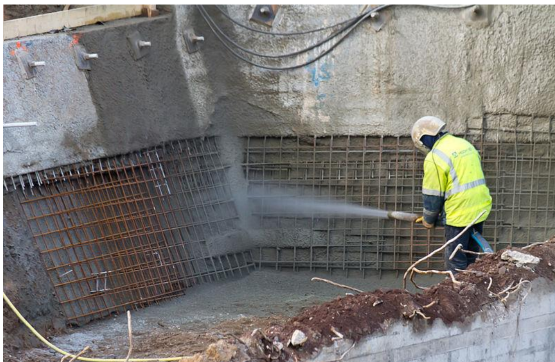
Εικόνα 10: Τοποθέτηση εκτοξευόμενου σκυροδέματος, Γερμανία (2013) (Wikipedia)
