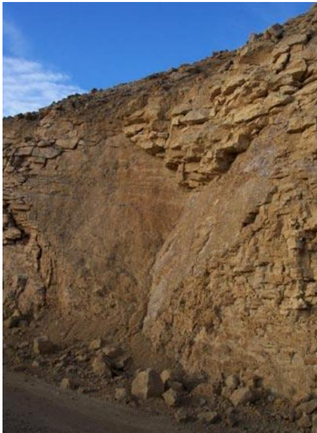
Εικόνα 7: Πρανές σε λατομείο, στο οποίο υπάρχουν ενδείξεις αστοχίας σφήνας. (British Geological Survey)
