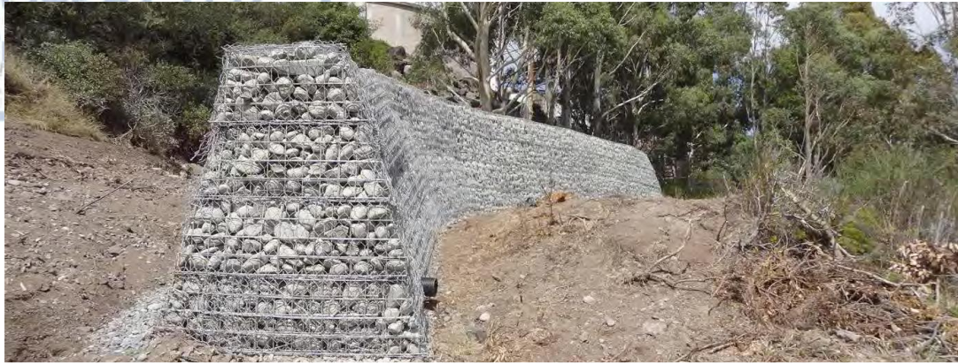
Εικόνα 11: Τοίχος αναχαίτισης, ενισχυμένος με συρματοκιβώτιο, Νέα Ζηλανδία (2016)
