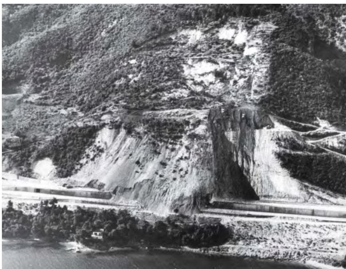
Εικόνα 1: Κατολίσθηση Παναγοπούλας Ν.Ε.Ο. Αθηνών - Πατρών, 1971. Περιστροφική ολίσθηση (τύπου εδάφους) σε κατακερματισμένο ασβεστόλιθο σε εναλλαγές με αργιλικούς σχιστόλιθους και πυριτιόλιθους. Λήψη από ελικόπτερο στις 28/04/1971, για τους σκοπούς της γεωτεχνικής μελέτης που εκπονήθηκε εκείνη την περίοδο από την ΓΕΩΕΡΕΥΝΑ ΑΕ. (Koukis et al, 2005)
