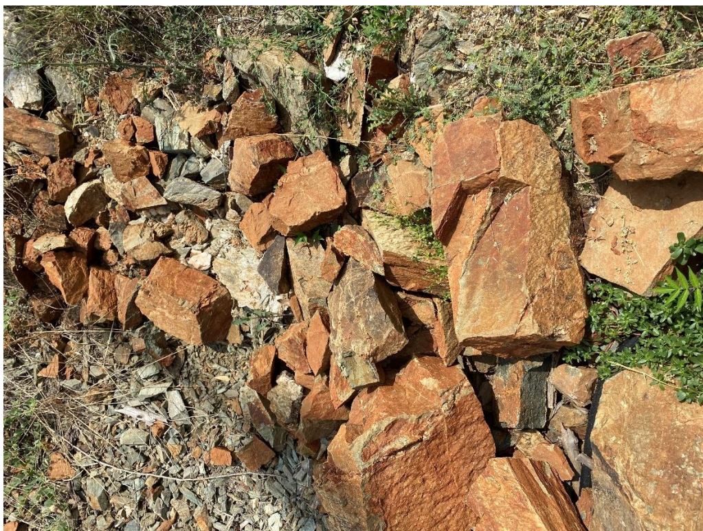
Εικόνα 24: Κατολισθαίνοντα τεμάχη στο σημείο μελέτης (2) – Ιούνιος 2023
