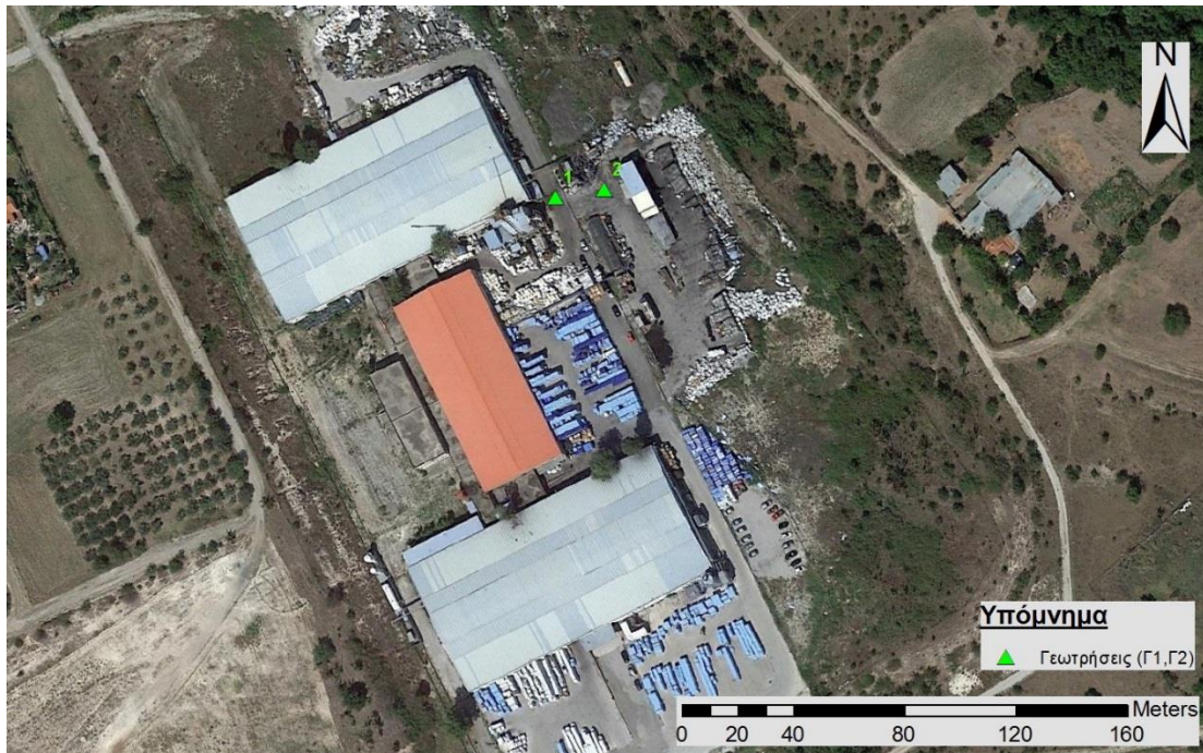
Εικόνα 8: Θέσεις διεξαγωγής δειγματοληπτικών γεωτρήσεων
