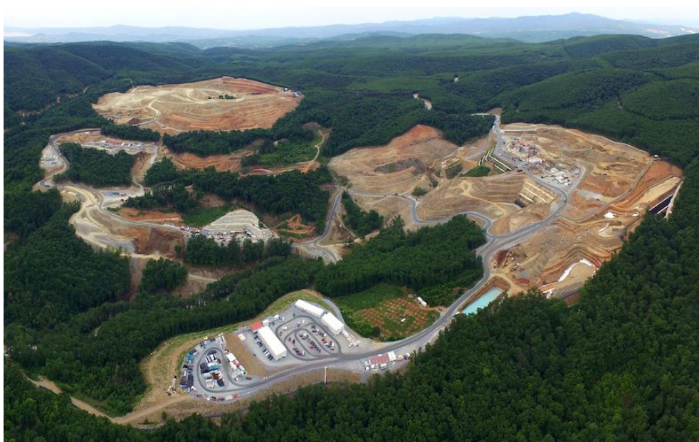
Σχ. 3.3. Αεροφωτογραφία του υπό ανάπτυξη μεταλλείου στην περιοχή των Σκουριών (eldoradogold.com)
