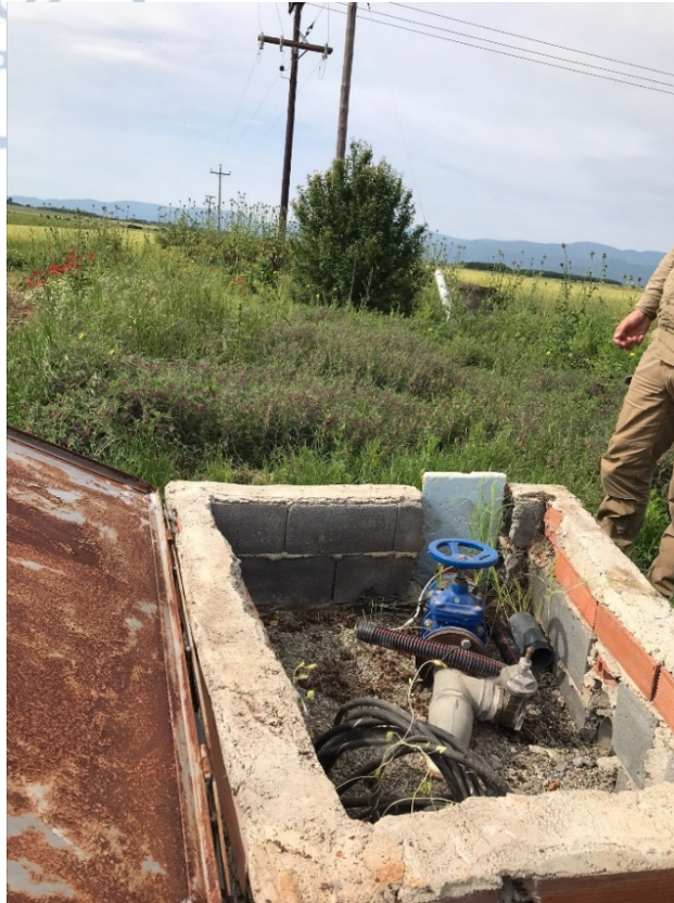
Γεώτρηση Νέος Καύκασος.
