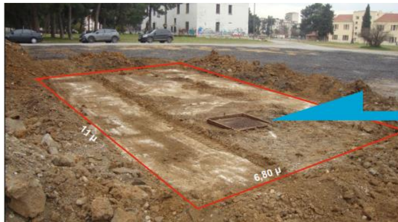
Εικόνα 5.5 Αποκάλυψη της μεταλλικής δεξαμενής του τέταρτου καννάβου
