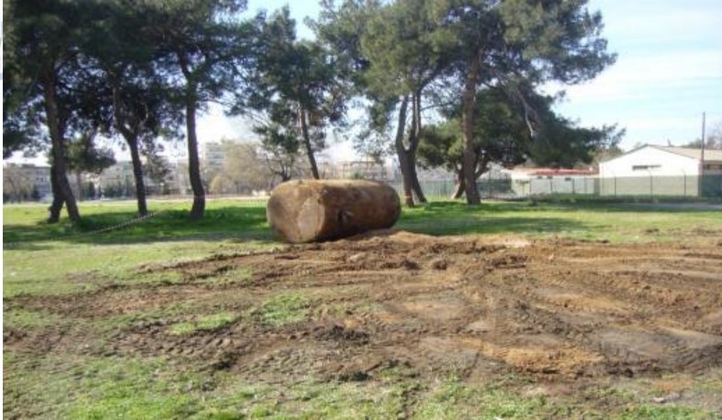
Εικόνα 5.4 Εξαγωγή μεταλλικής δεξαμενής του τρίτου καννάβου
