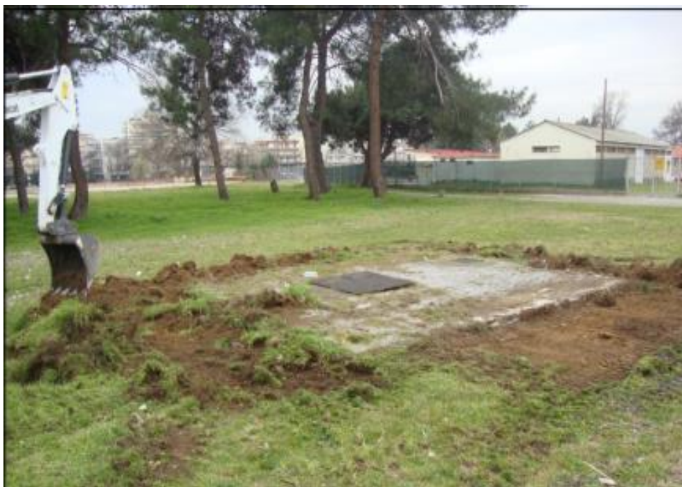
Εικόνα 5.1 Αποκάλυψη της δεξαμενής του πρώτου καννάβου
