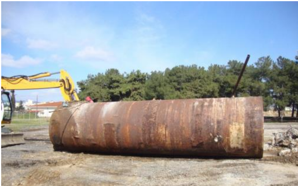
Εικόνα 5.7 Εξαγωγή μεταλλικής δεξαμενής μήκους 8.00m και διαμέτρου 2.20m
