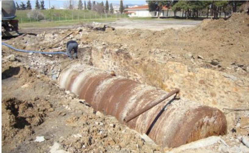
Εικόνα 5.6 Μεταλλική δεξαμενή πριν την εξαγωγή της.
