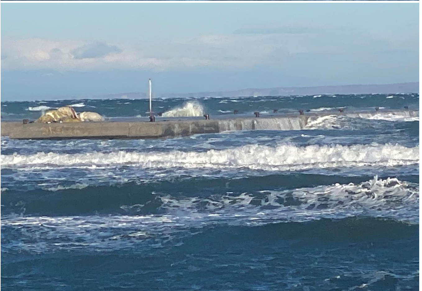
Εικόνα 61 Κάθετος πρόβολος στην ΒΑ πλευρά του λιμανιού .Η υπερπήδηση των κυμάτων είναι εμφανής καθιστώντας τον ανενεργό σε αυτές τις καιρικές συνθήκες.
