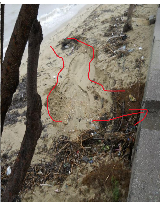
Εικόνα 78 Το κενό στο ρείθρο του πεζοδρόμου είναι ο νέος αγωγός όμβριων υδάτων .Εύκολη είναι η παρατήρηση της μεγάλης εξάμωσης που προκαλούν μετρά από έντονη βροχοπτωση.2014
