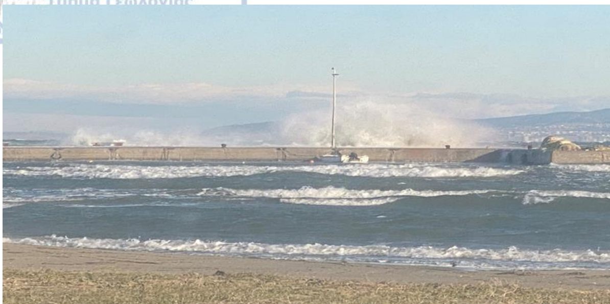
Εικόνα 15 Το κύμα έχει προσκρούσει στο προσήνεμο μέτωπο της κατασκευής. Νοε 2023
