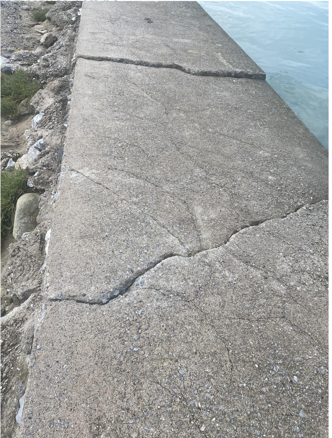
Εικόνα 29 Κατακερματισμένη επιφάνεια στέψης
