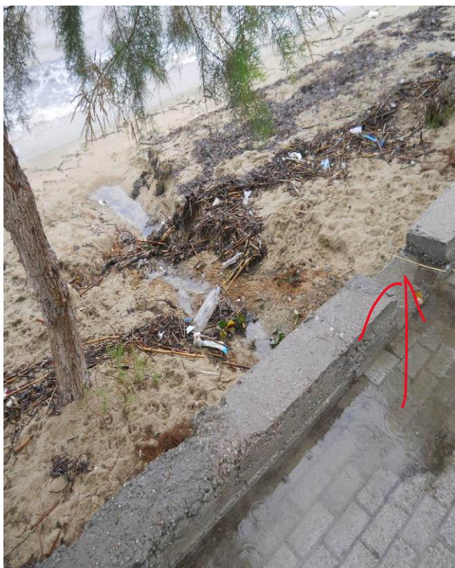
Εικόνα 78 Το κενό στο ρείθρο του πεζοδρόμου είναι ο νέος αγωγός όμβριων υδάτων .Εύκολη είναι η παρατήρηση της μεγάλης εξάμωσης που προκαλούν μετρά από έντονη βροχοπτωση.2014
