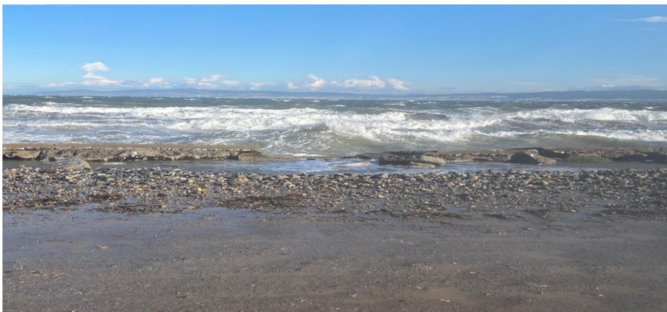
Εικόνα 32 Κατεστραμμένη στέψη, η κατακερματισμένη επιφάνεια στέψης έχει ολίσθησή και έχει καταπέσει εμπρός από την επιφάνεια του τοίχου
