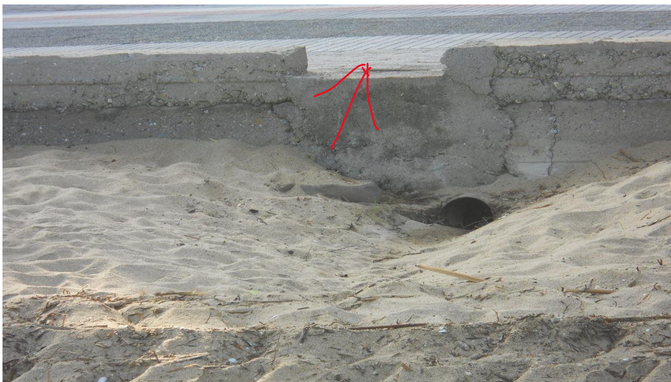
Εικόνα 71 Αγωγός όμβριων οδού
