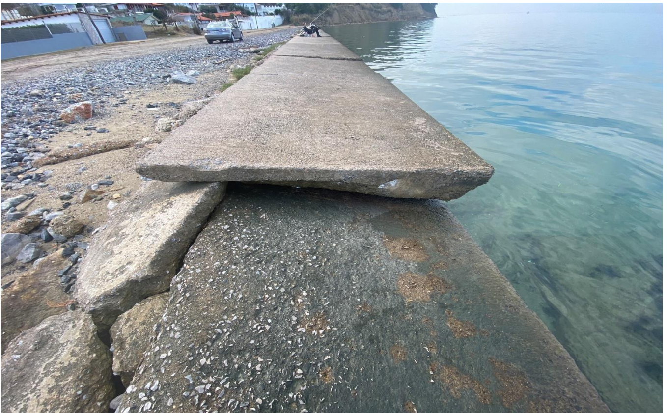
Εικόνα 30 Κατακερματισμένη επιφάνεια στέψης
