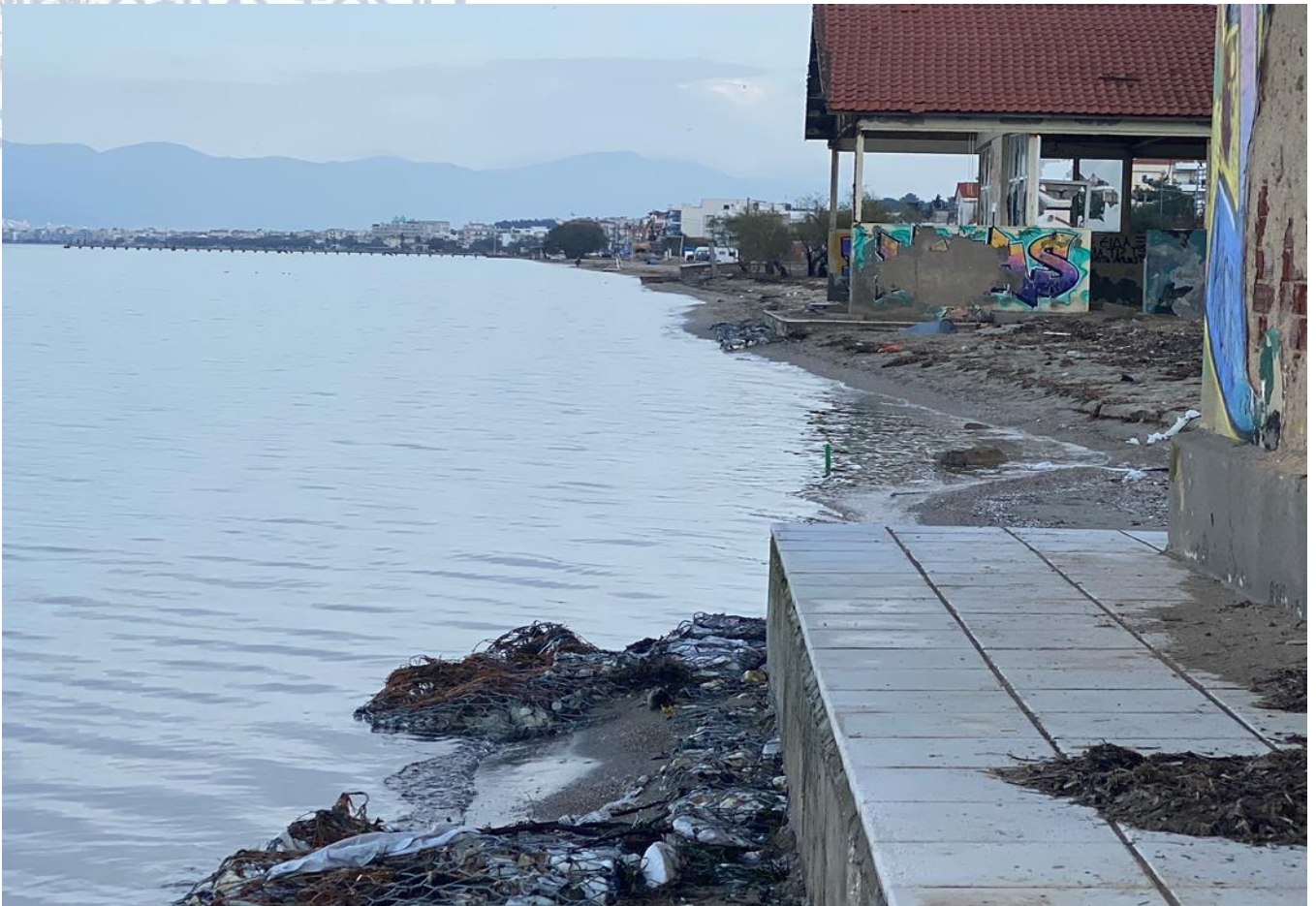
Εικόνα 45 Δεύτερο κτήριο σχεδόν κατεδαφισμένο λόγω του κίνδυνου της κατάρρευσης εξ αίτιας της διάβρωσης Νοε 2023
