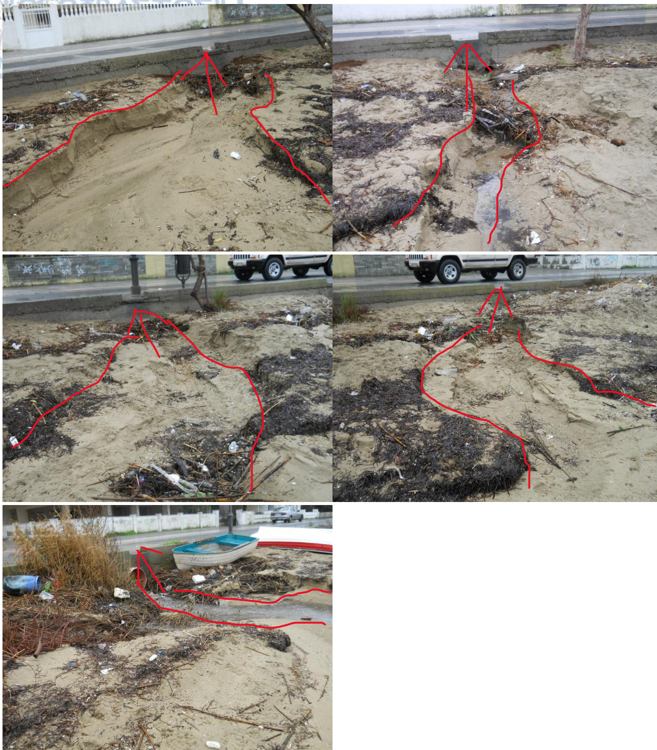
Εικόνα 79 Μετά από έντονη βροχόπτωση παρατηρούμε αυτήν εκβάθυνση της ακτής εξ αιτίας των αγωγών ομβριων.2014
