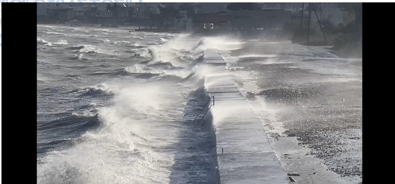
Εικόνα 33 Εμφανής η υπερπήδηση της στέψης του κρηπιδοτοιχου
