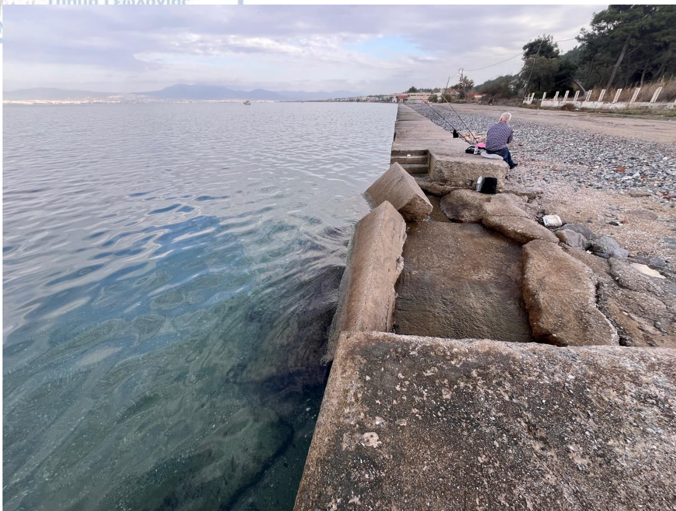
Εικόνα 32 Κατεστραμμένη στέψη, η κατακερματισμένη επιφάνεια στέψης έχει ολίσθησή και έχει καταπέσει εμπρός από την επιφάνεια του τοίχου
