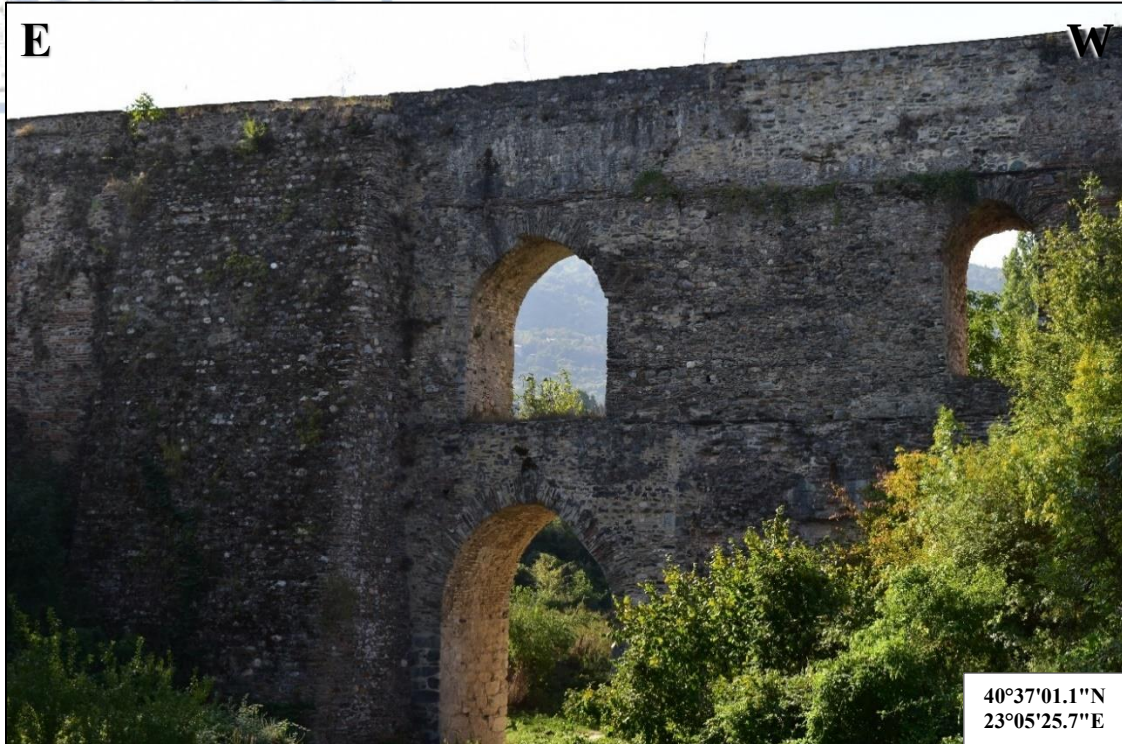
Εικόνα 4.22. : Ρωμαϊκό Υδραγωγείο Χορτιάτη
