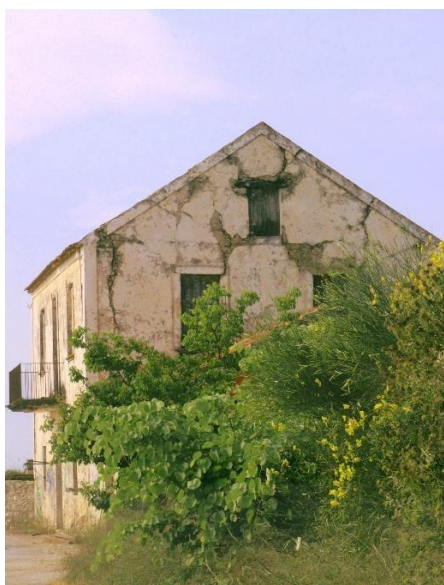
Εικόνα 3. Περιοχή Ερισσού, Κεφαλονιά: Παλιά κατοικία που έχει πληγεί από τον καταστροφικό σεισμό του 1953.
