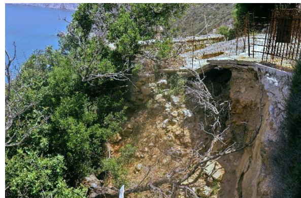
Εικόνα 16. Αστοχίες και υλικές ζημιές της μονής, που έχει προκαλέσει η έντονη σεισμική δραστηριότητα του νησιού.
